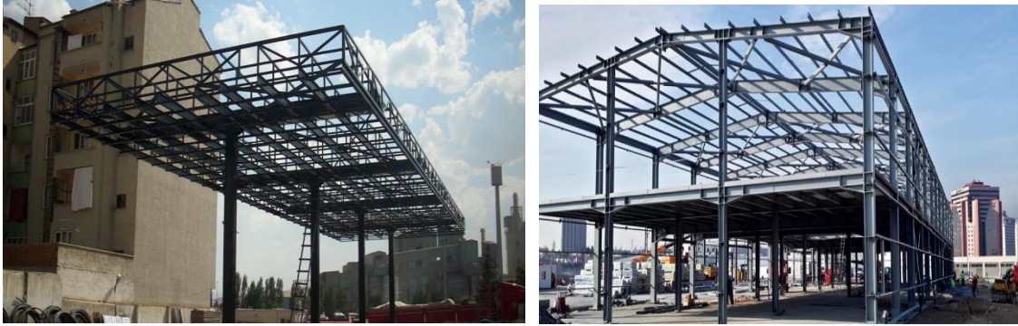
Resim 1.1. İnce cidarlı taşıyıcı elemanların yapı mühendisliğinde kullanımı
