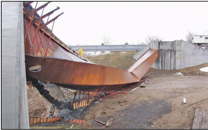
Resim 1.3. Yanal burulmalı burkulma deforme olmuş kiriş
