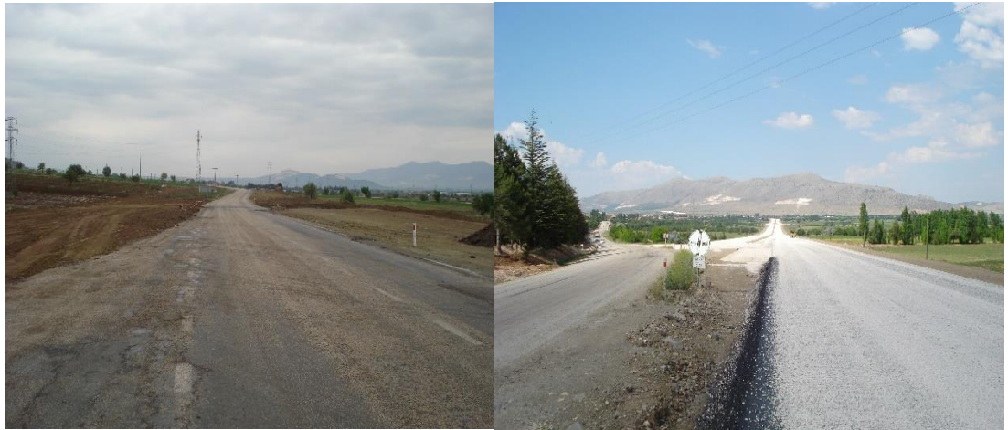
Şekil 3.5. Karamanlı-Tefenni yolu (Üst: yol haritası; Alt sol: Eski yol; Alt sağ: ıslah edilerek yenilenmiş-bölünmüş yol) (KGM)
