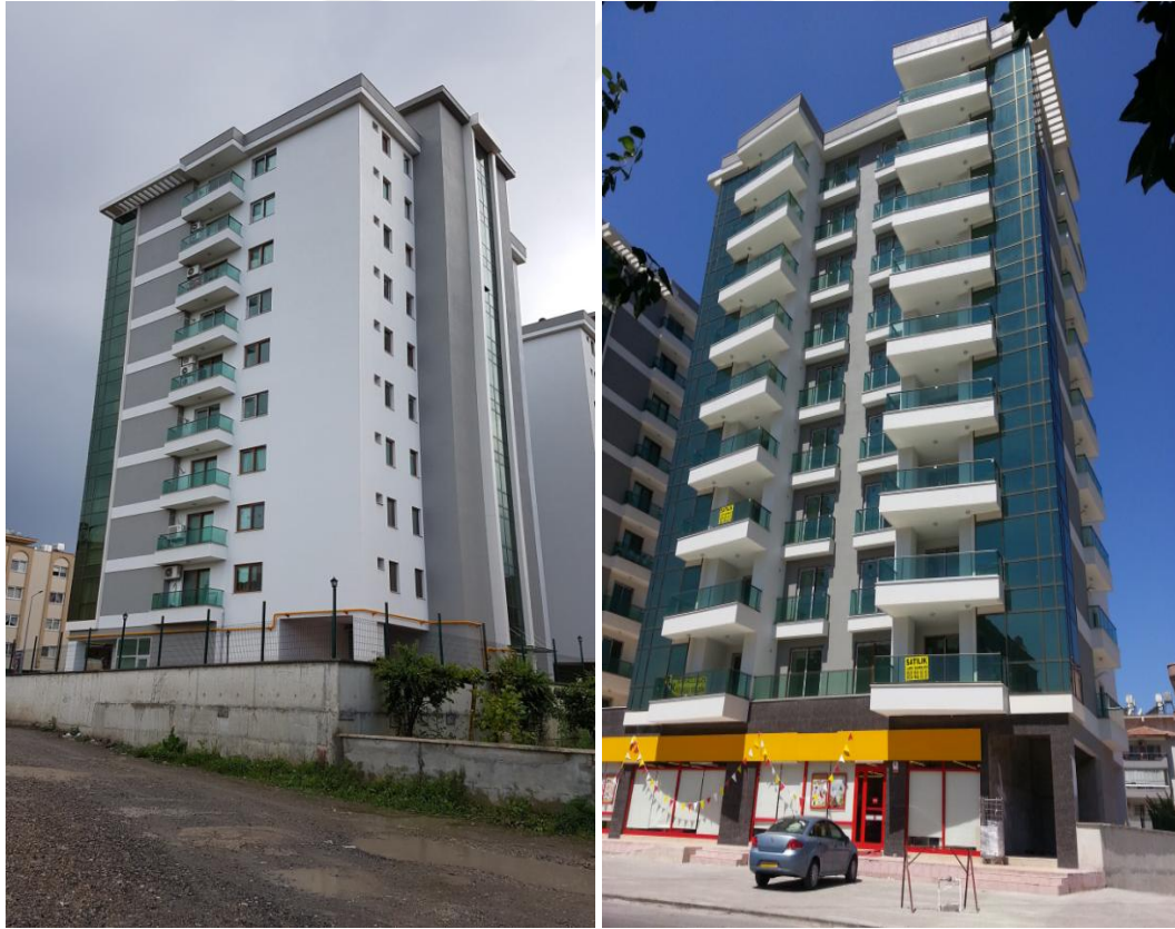
Şekil 3.8. Tamamlanmış bina cephe görünüşleri
