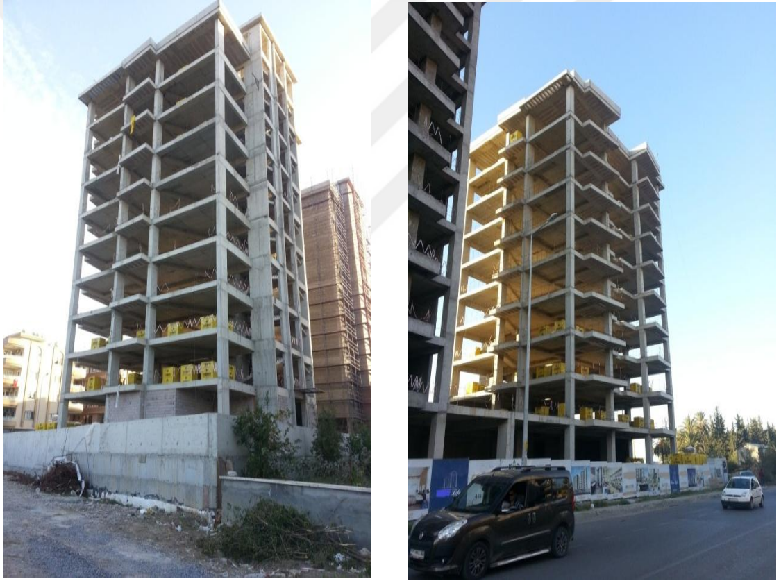
Şekil 3.4. Bina taşıyıcı sistemin cephe görüntüleri
