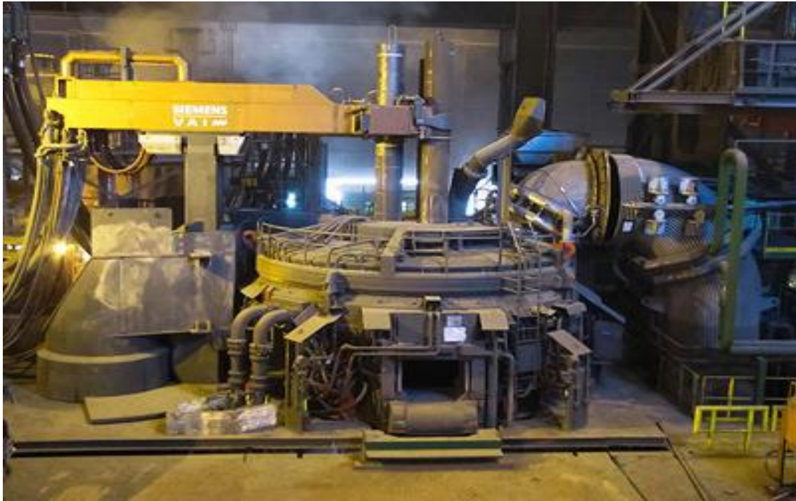
Şekil 4.12. Elektrikli ark fırını
