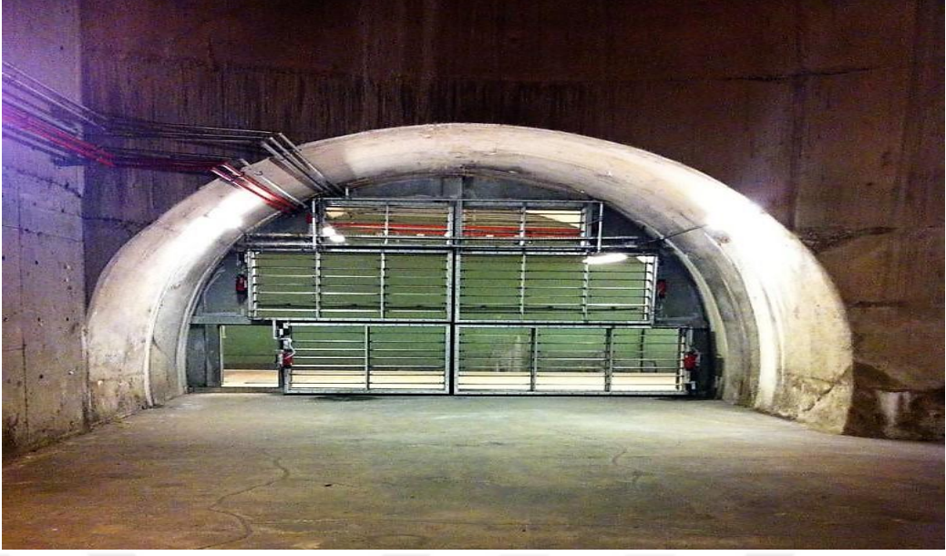
Şekil 2.2 Tünel havalandırma şaftı
