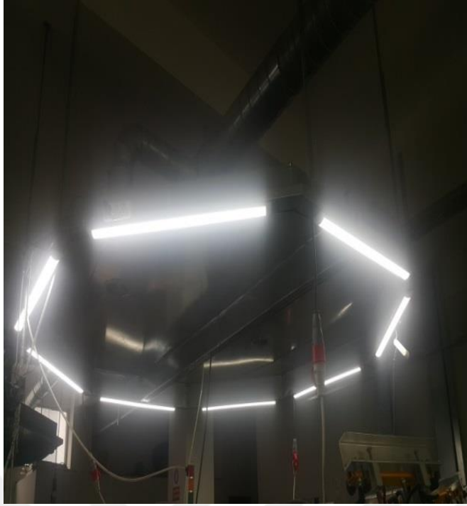
Şekil 4.10. Havai hatta elektrik kabloları.
