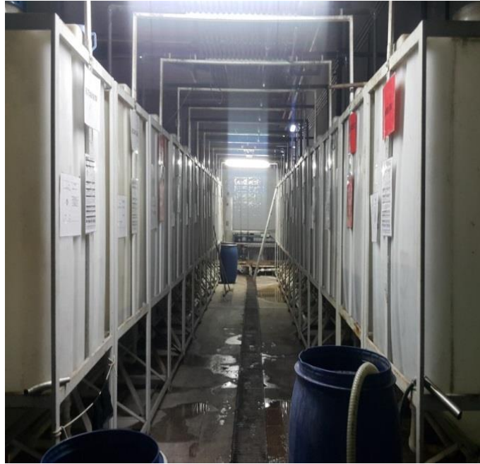
řekil 4. 2. Otomatik dozajlamanın yapıldıėı kimyasal tanklar.
