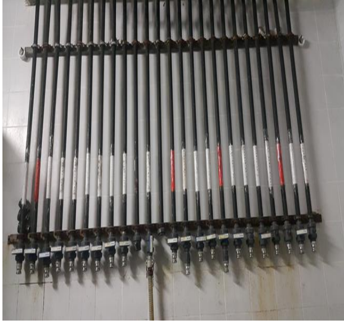
Şekil 4. 3. Otomatik dozajlama boruları
