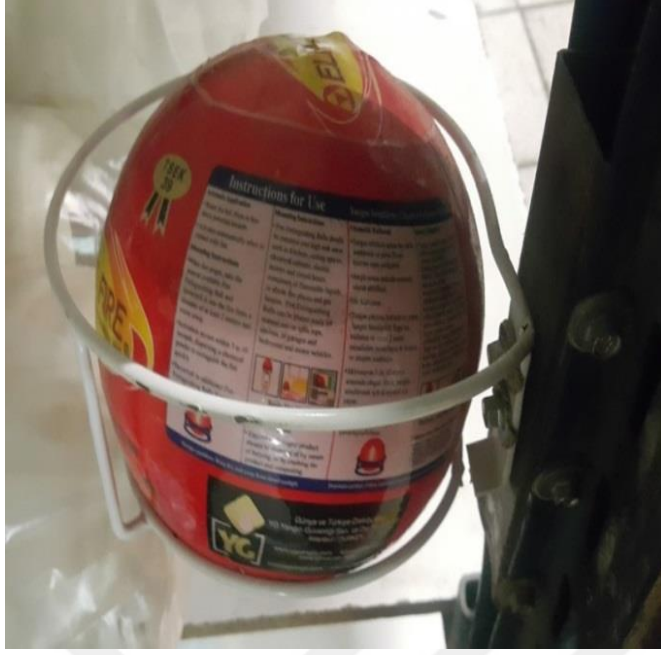
Şekil 4.17. Yangın söndürme topu.
