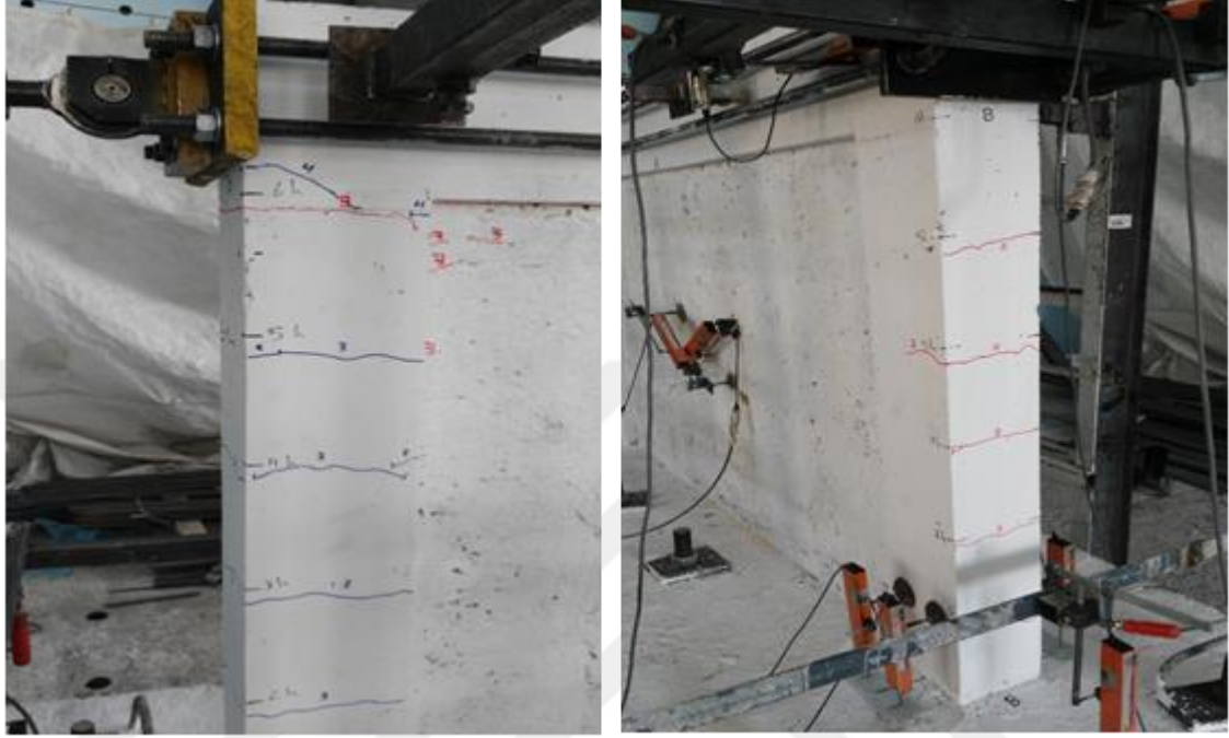
Şekil 3.27. Üçüncü ve dördüncü döngü sonunda oluşan çatlaklar.
