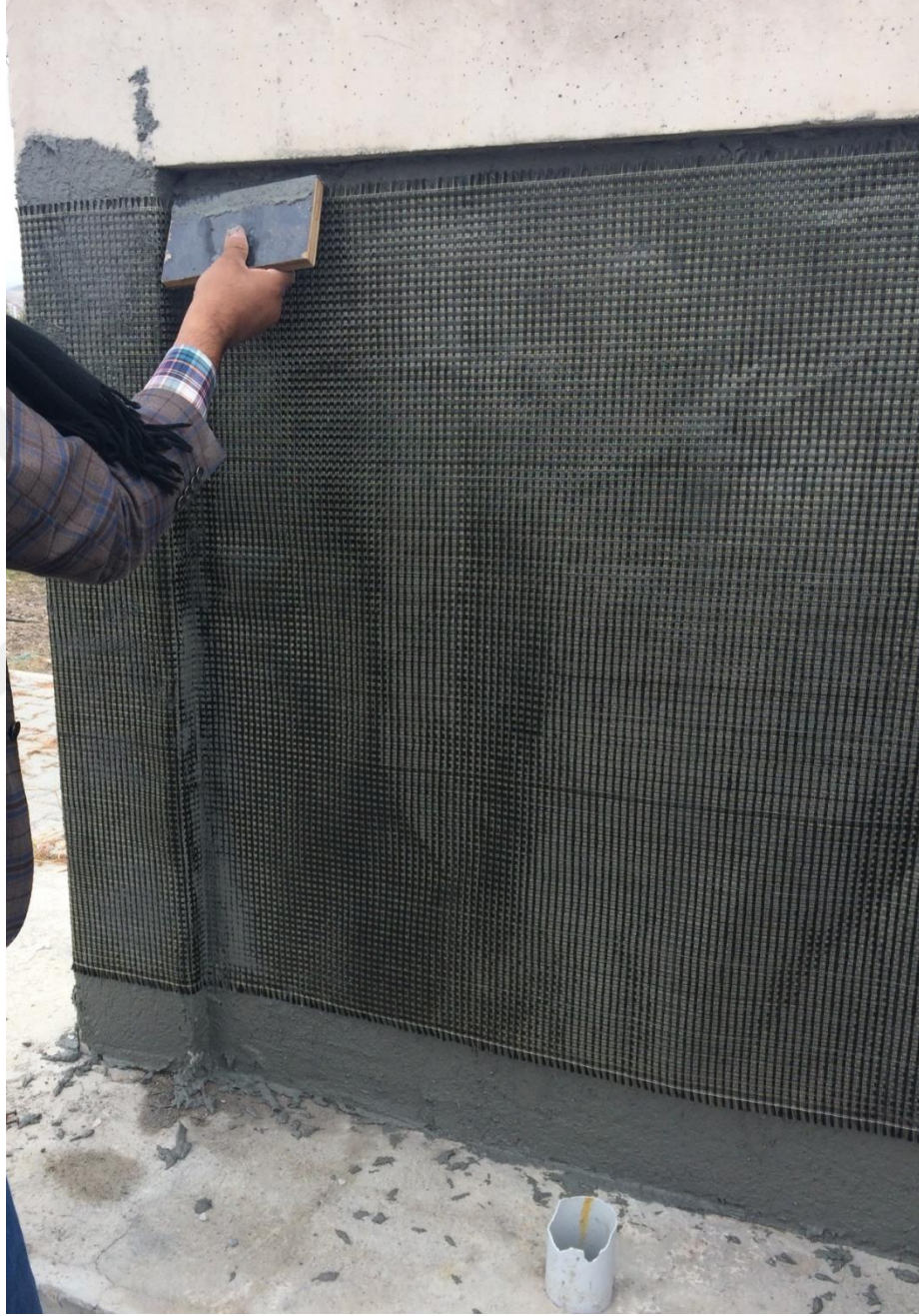
Şekil 3.16. Karbon fiber matrisli FRCM uygulanan numune.
