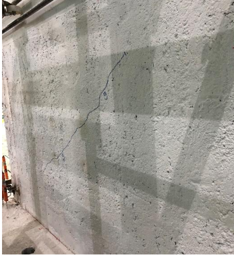
Şekil 3.39. Dolgu duvarda meydana gelen diagonal çatlaklar.
