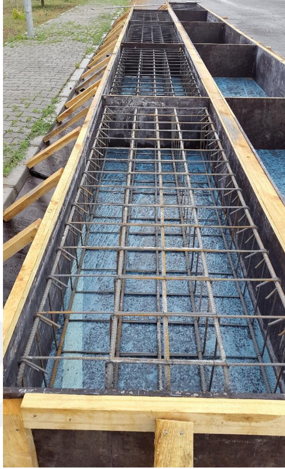
Şekil 3.4. Temel donatılarının hazırlanması.
