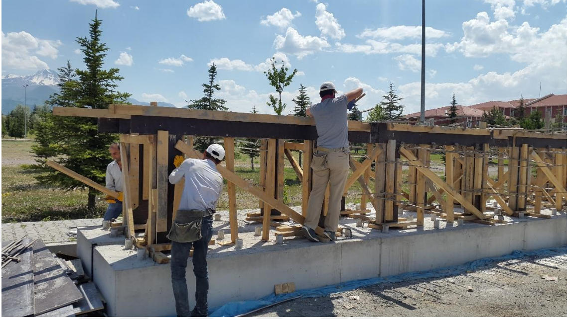
Şekil 3.6. Kolon ve kiriş donatı ve kalıplarının hazırlanması.
