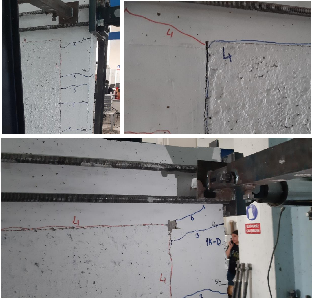
Şekil 3.33. Altıncı döngüye kadar meydana gelen çatlaklar.
