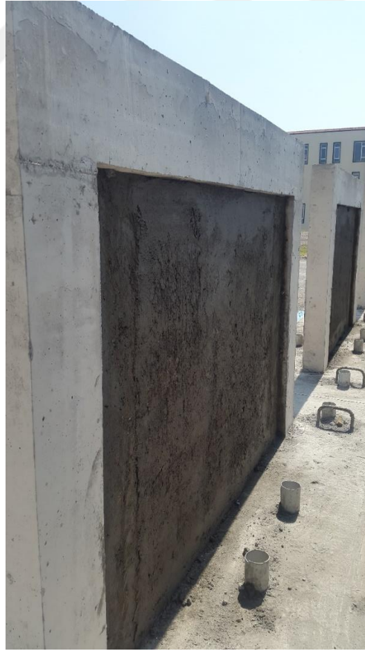
Şekil 3.12. Sıva uygulanmış iç yüzey.
