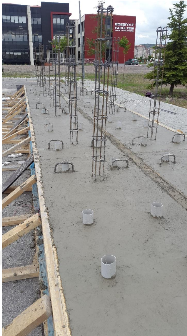
Şekil 3.5. Filiz ve bağlantı boşluklu küre bırakılmış temel numuneleri
