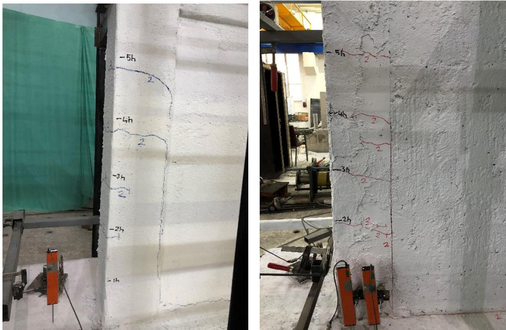
Şekil 3.37. İkinci döngüde meydana gelen çatlaklar.
