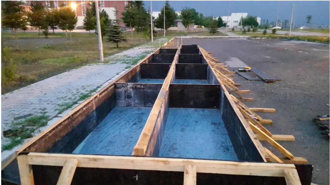
Şekil 3.3. Temel kalıplarının hazırlanması.
