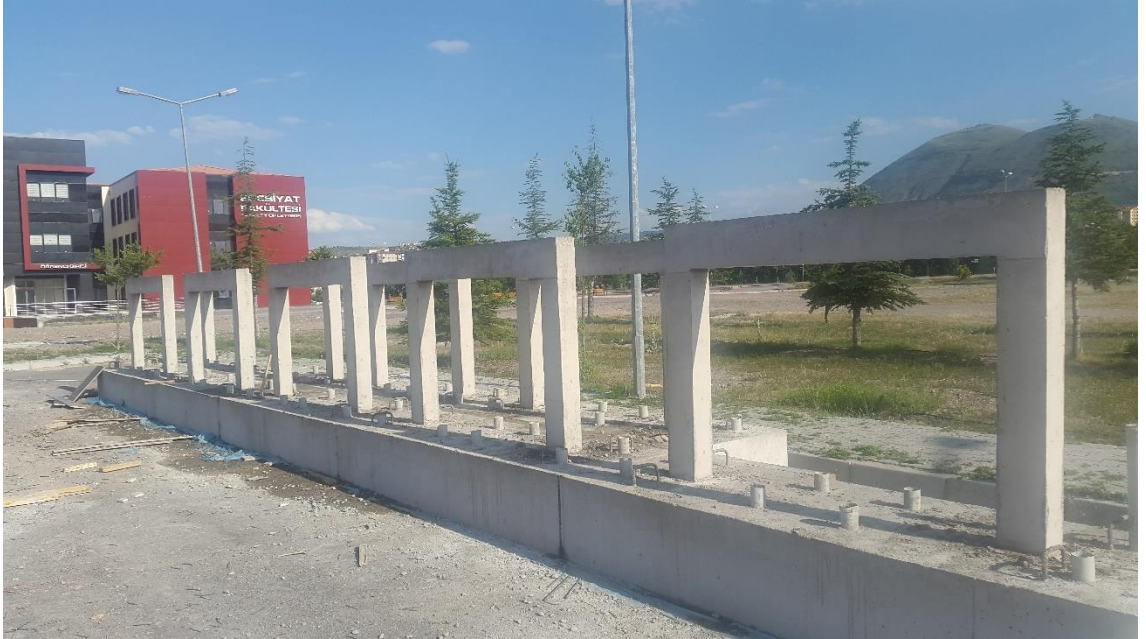
Şekil 3.7. Betonarme çerçevelerin kalıplarının sökülmüş hali.
