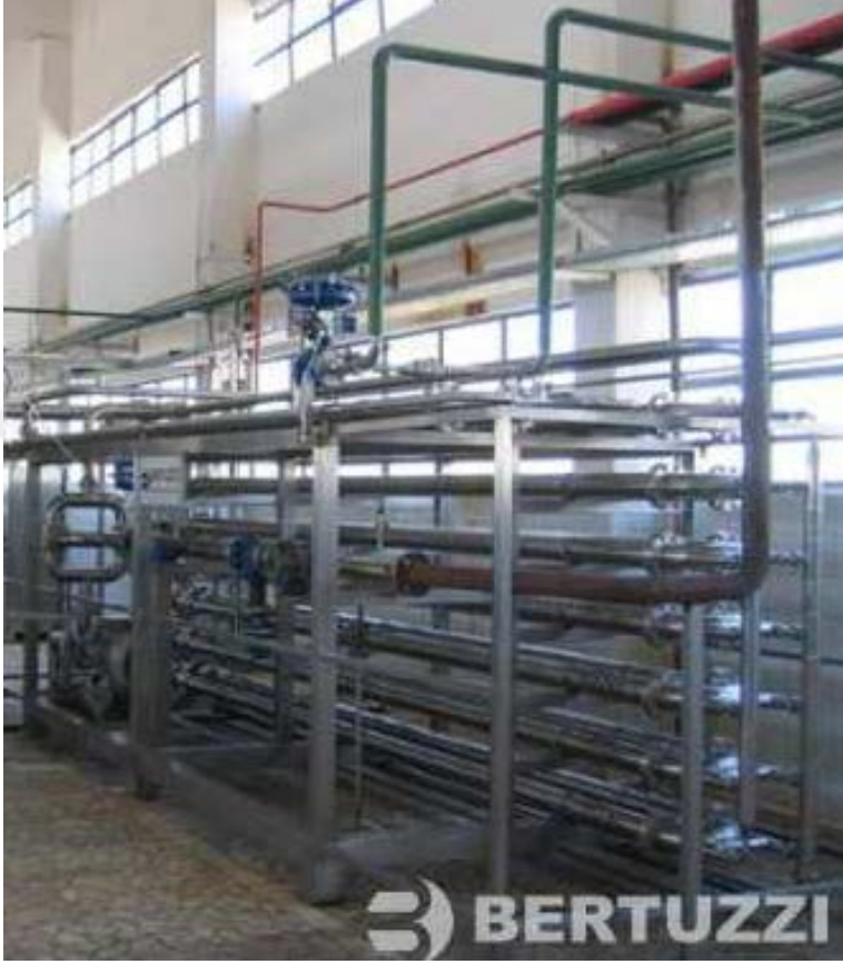
Şekil 3.7 Mayşe ısıtma için kullanılan bir tubular ısı deęiřtirici (Bertuzzi, 2019)
