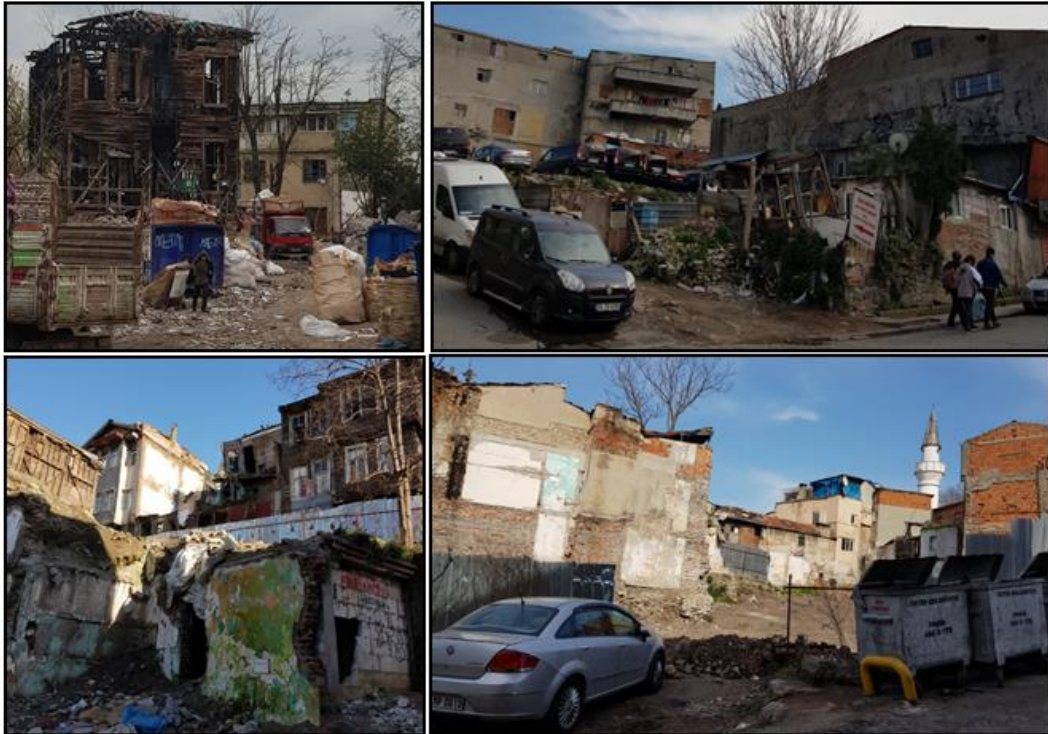
Şekil 4.88 : Alanda oluşan kirlilik (Kaynak: Çalışma kapsamında çekilmiştir, 2019).
