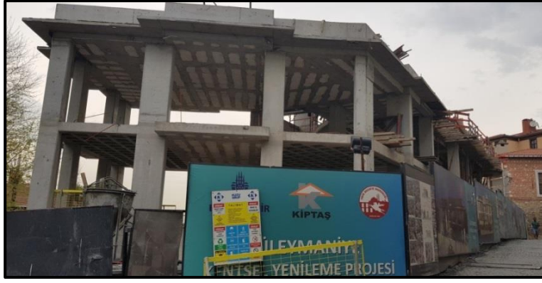
Şekil 4.18 : 508 Adada yapılan inşaat çalışmaları (Kaynak: Çalışma kapsamında 2019 yılı Nisan ayında çekilmiştir).
