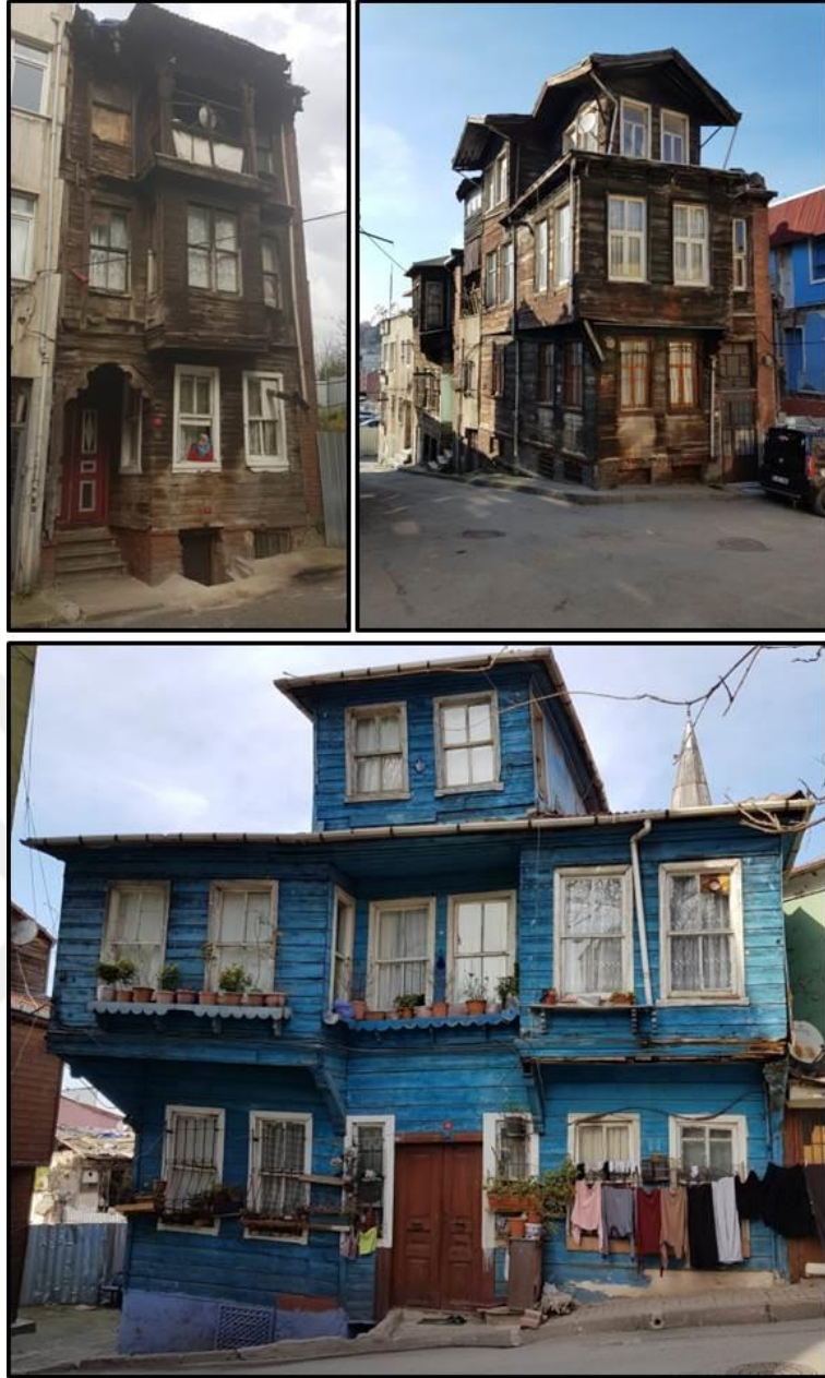
Şekil 3.10 : Süleymaniye bölgesinde bulunan ahşap yapı örnekleri (Kaynak: Çalışma kapsamında çekilmiştir, 2019).
