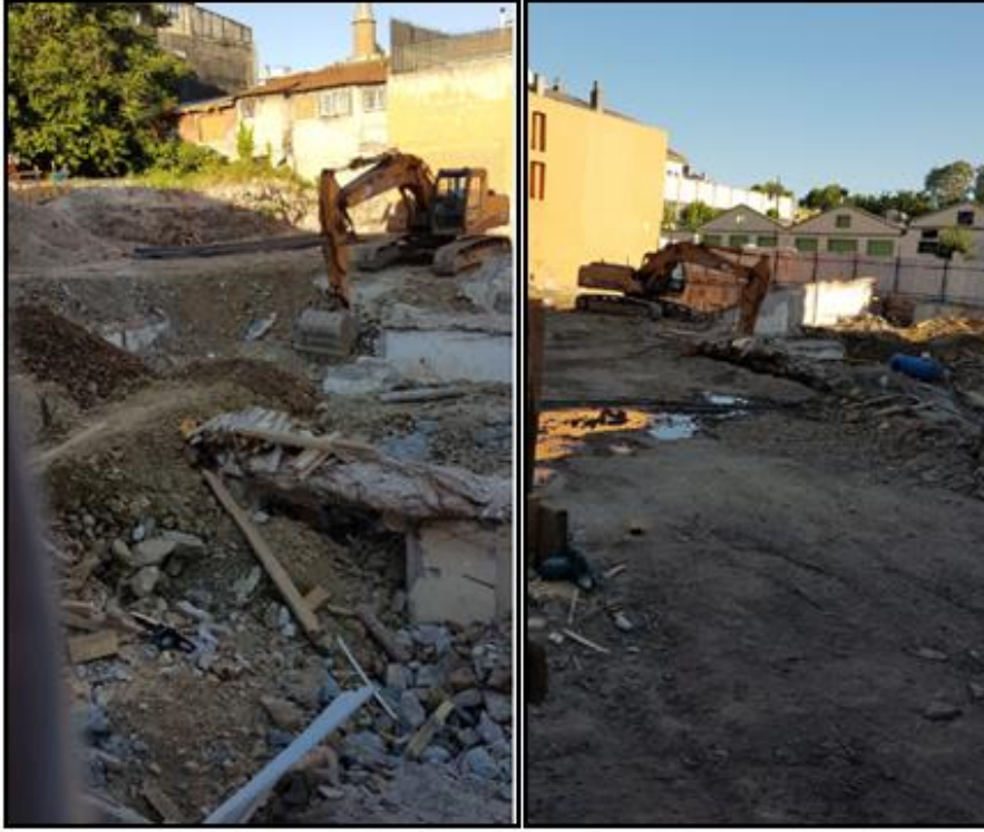
Şekil 4.54 : 962 Adada yapılan inşaat çalışmaları (Kaynak: Çalışma kapsamında 2019 yılı Nisan ayında çekilmiştir).
