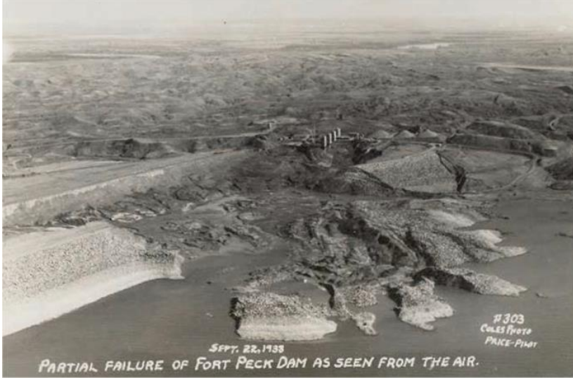
Şekil 3. 1 Montana Fort Peck Barajı akma yenilmesi ( https://damfailures.org/case-study/fort-peck-dam-montana-1938/ , 5.9.2022 tarihinde erişildi.)
