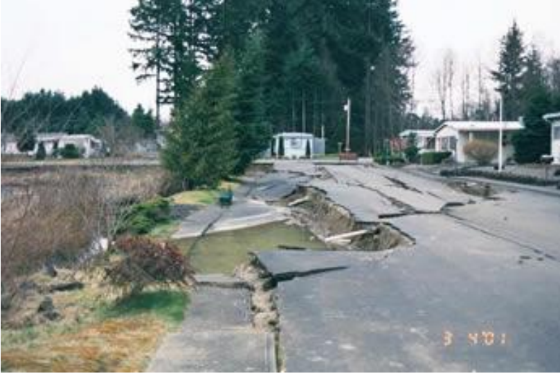
Şekil 3. 4 Tumwater'da Sunset gölü karavan parkının batı kısmında meydana gelen yanal yayılma (www.earthquake.usgs.gov, 5.9.2022 tarihinde erişildi.)
