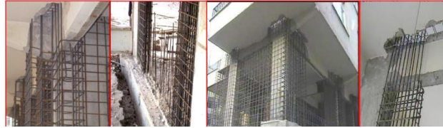
Şekil 3.2. Betonarme perde ilavesi ve kolon mantolama (Atmaca 2013)
