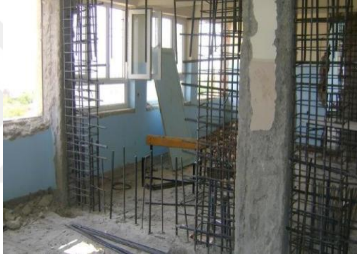
Şekil 2.1. Betonarme perde ilavesi için donatı ekimi (Kavşut 2012)
