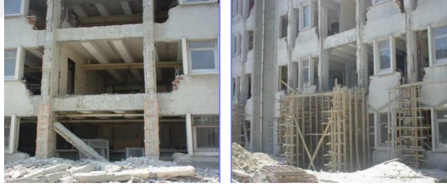
Şekil 2.3. İ.Ü. Mühendislik Fakültesi binası dış perde ile güçlendirme uygulaması (Ören 2010).
