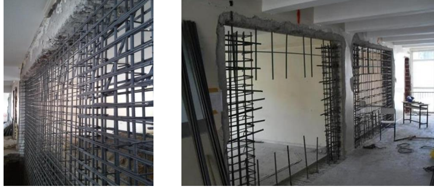
Şekil 3.1. Betonarme perde ilavesiyle ile güçlendirme (Kan 2020)
