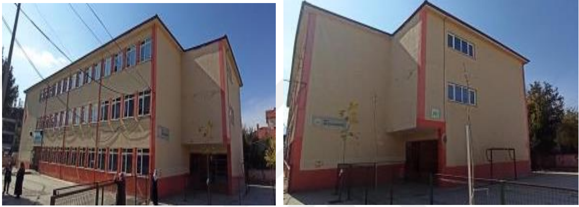
Şekil 6.1. Mevcut okul binası
