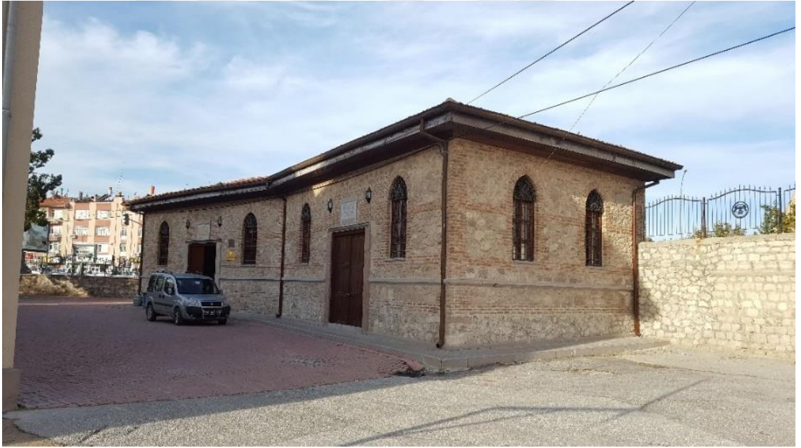
Fotoğraf 55 Yan Cepheden Görünüş
