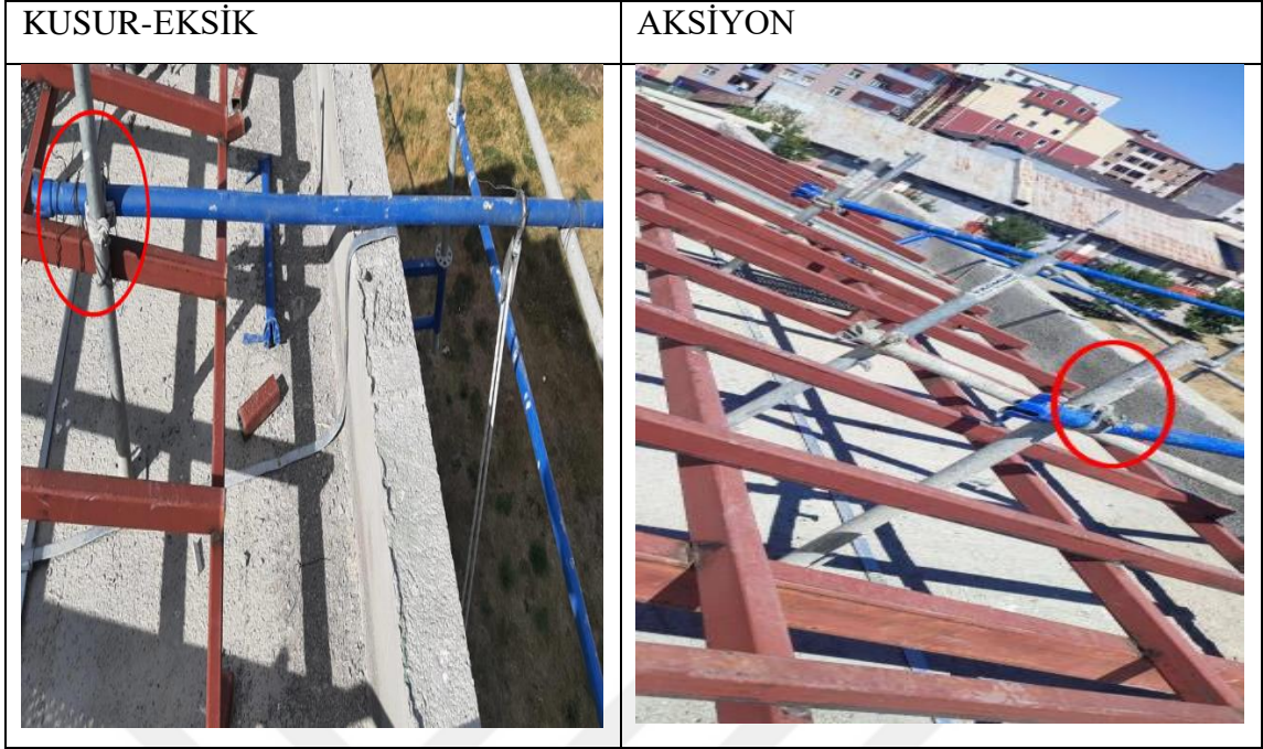
Şekil 4.28: İskele motajında görülen kusur ve aksiyon
