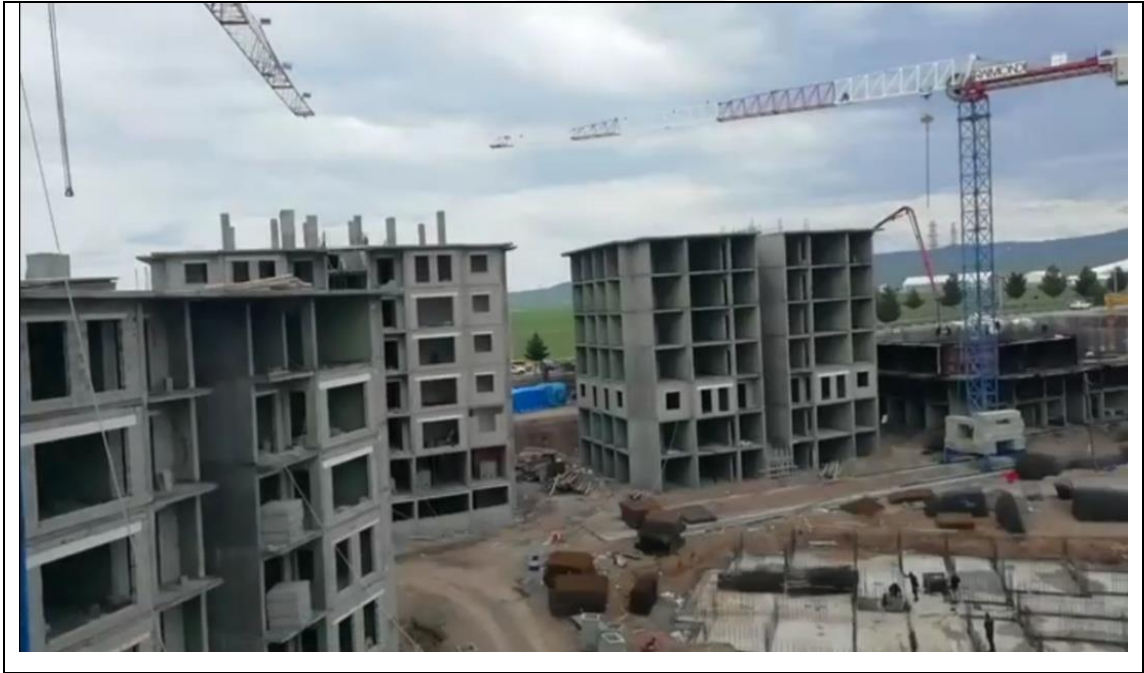
Şekil 3.4: Hera teknik Kars 327 konutlu Toki Şantiyesi
