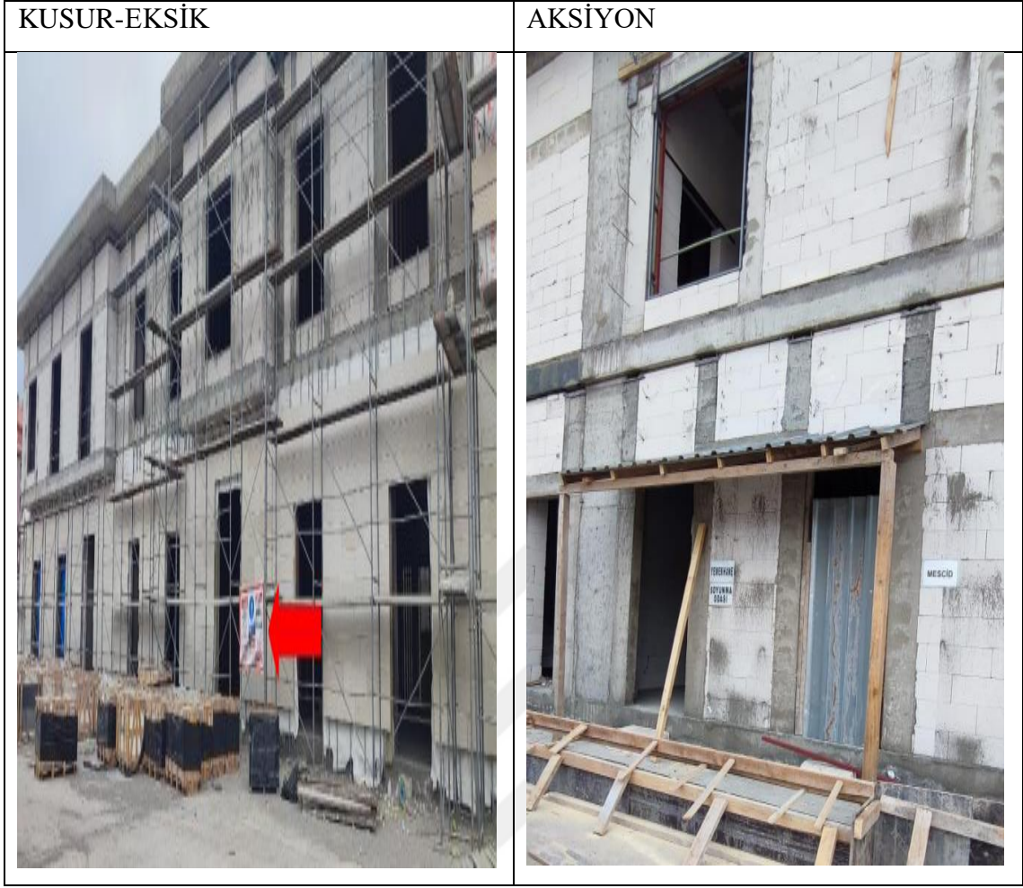
Şekil 4.26: Yapı giriş çıkışlarında görülen kusur ve aksiyon
