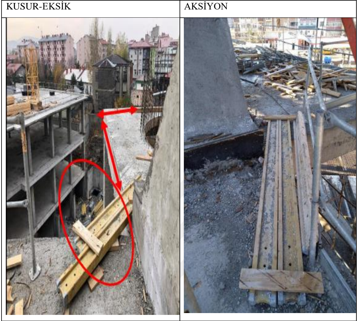
Şekil 4.2: Geçiş platformu kusur ve aksiyon
