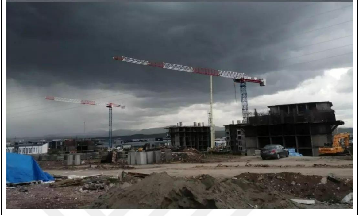
Şekil 3.3: Hera teknik Kars 327 konutlu Toki Şantiyesi
