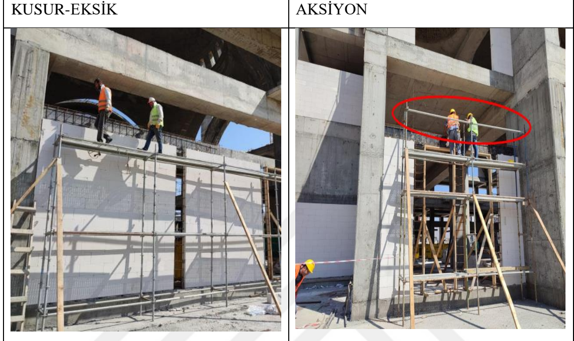
Şekil 4.16: İskele kullanımında görülen kusur ve aksiyon
