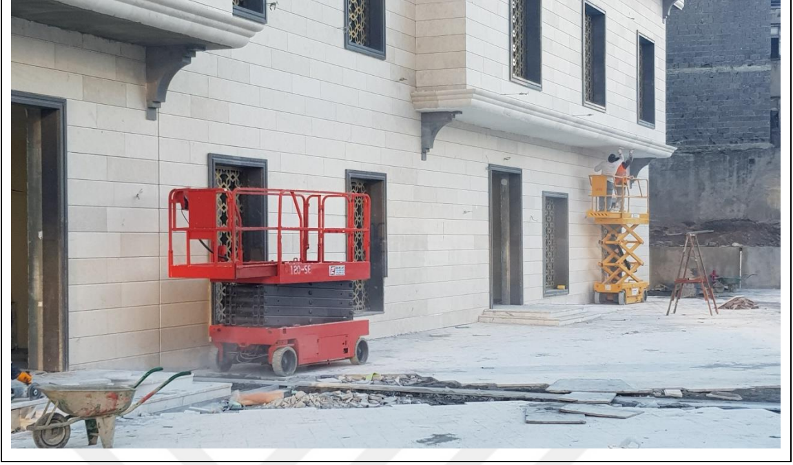
Şekil 1.23: Mobil iş platformlarının kullanımı
