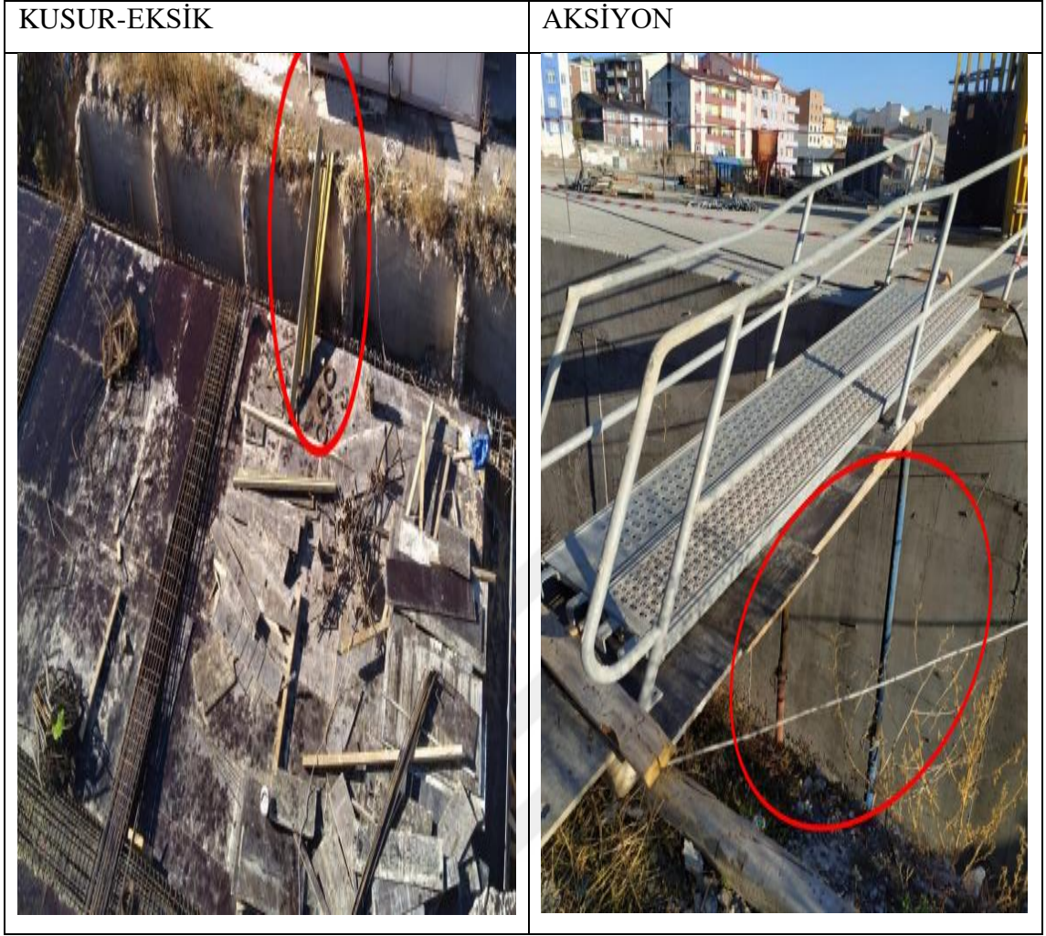
Şekil 4.5: Geçiş platformları kusur ve aksiyon
