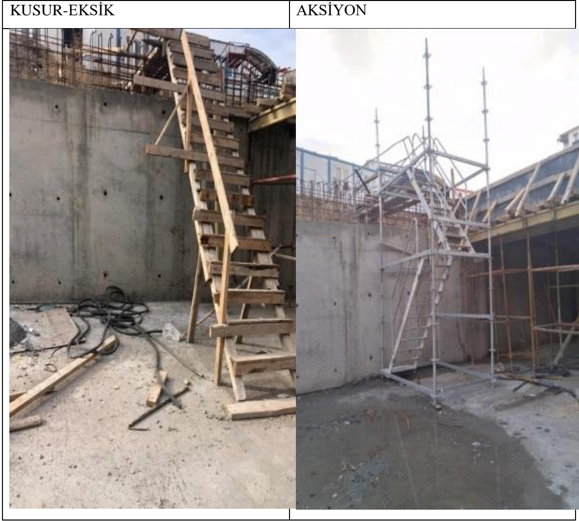
Şekil 4.3: Merdiven kusur ve aksiyon
