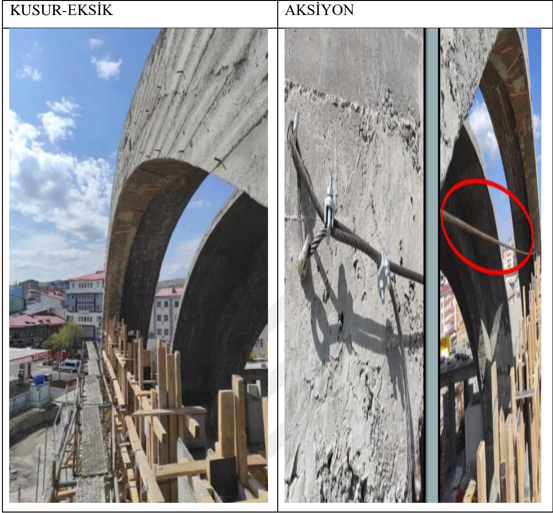
Şekil 4.8: Yüksekte çalışmada kusur ve aksiyon
