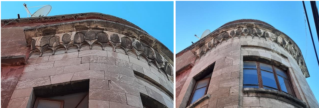
Şekil 4.109. 5.mıntıka 1549 parsel cephesinde yer alan geometrik taş işleme (Kayış, T. 2022)
