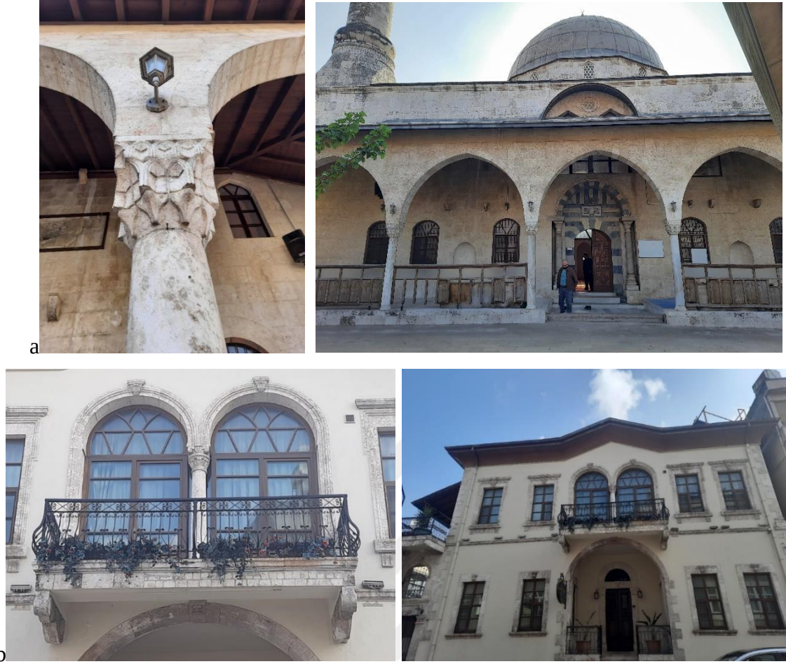
Şekil 4.107. Neoklasik üslupta sütun başlığı, kemer ve söve örneği (Kayış, T. 2022) a.) 4.Mıntıka 827 parsel (Şeyh Ali Cami) b.) 3.Mıntıka 1237 parsel (Çankaya Otel)
