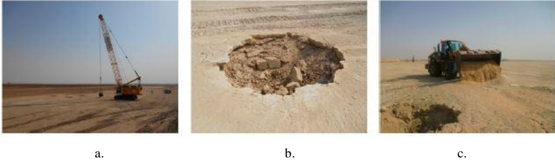
Görsel 1.9. Dinamik kompaksiyon uygulaması a. Tokmağı taşıyan vinç b. Tokmaktama sonrası oluşan krater c. Kraterin iyi derecelenmiş kumlu zeminle doldurulması (Moon vd. 2019)
