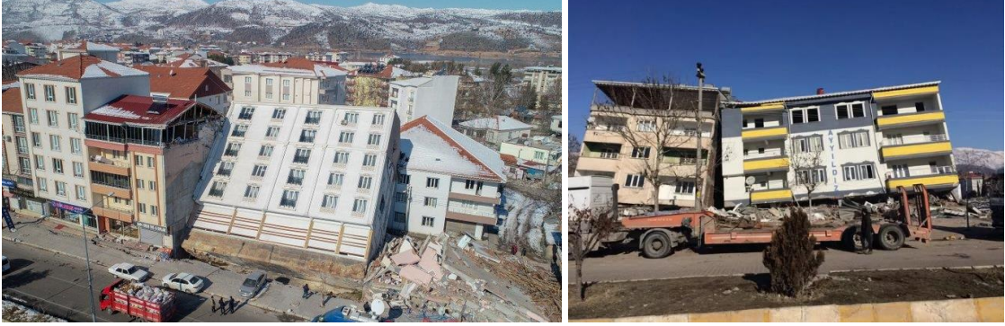
Görsel 1.1. 7,7 ve 7,6 Maraş depremleri sonucu sıvılaşma görülen binalar ( http-1 )
