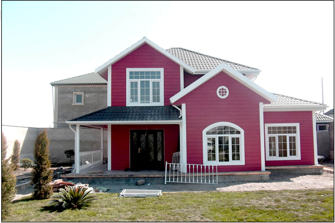
Şekil 4. 4. Yalı baskı uygulamasıyla fibercement kaplı prefabrik bir ev (Anonim 9)
