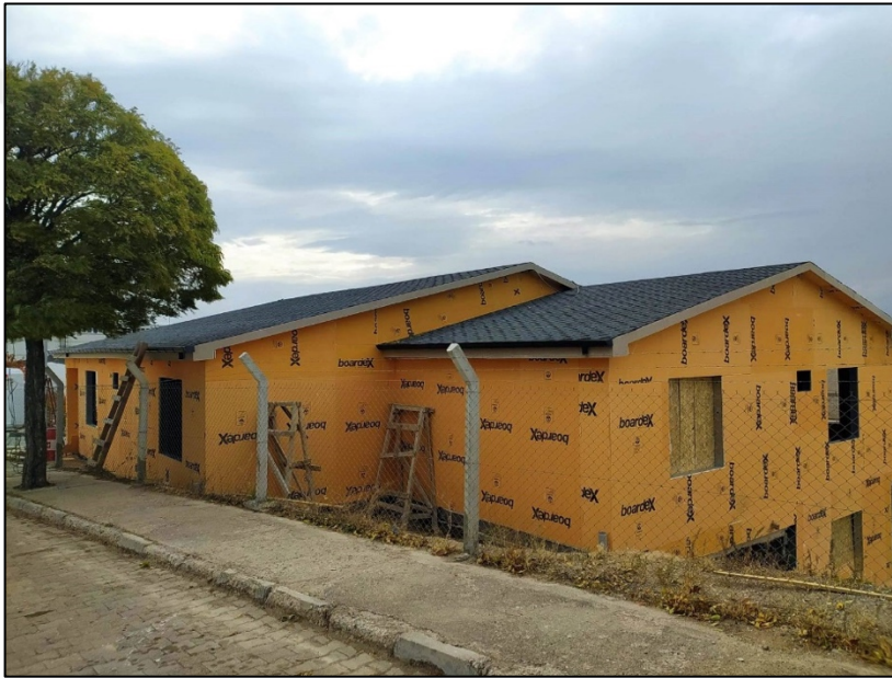
Şekil 4. 9. Hafif çelik yapılarda cam elyaf şilte kaplı levha cephe uygulaması, Yozgat (Orijinal 2022)
