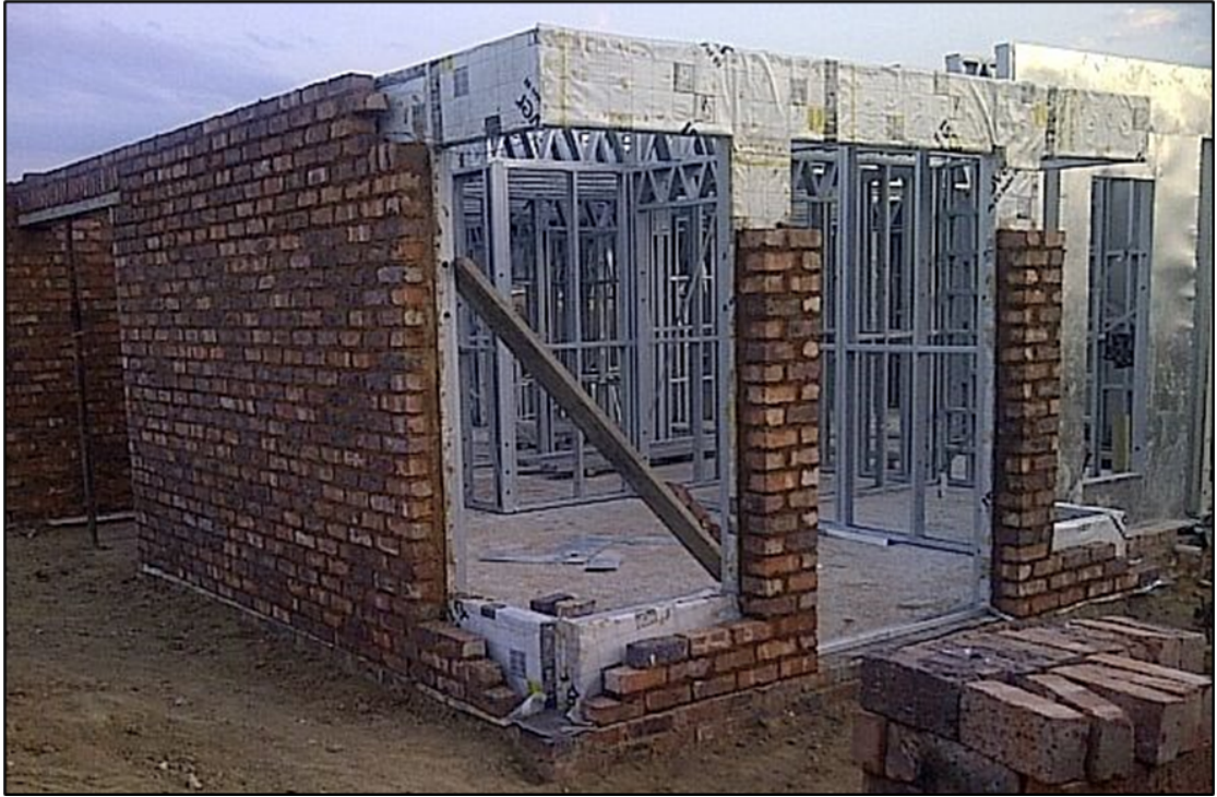
Şekil 4. 13. Hafif çelik dış cephe tuğla kaplama (Anonim 4)
