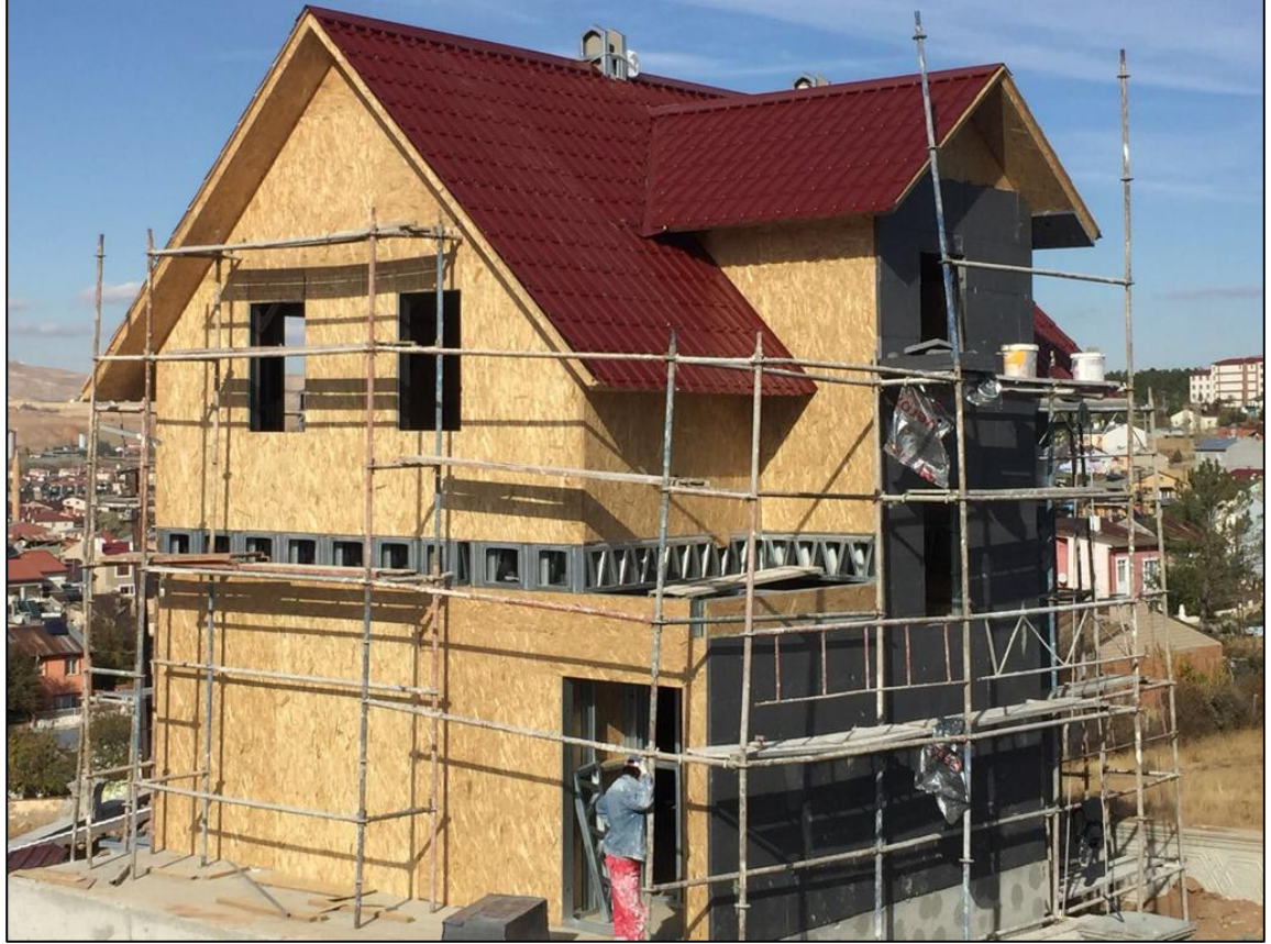
Şekil 4. 2. Hafif çelik yapı dış cephe OSB kaplama (ZMS Çelik arşivi)
