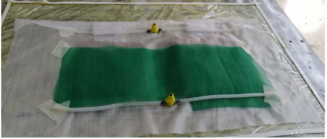
Şekil 2.7 Peel ply malzemesi ve epoksi filesinin sisteme yerleştirilmesi (Kişisel arşiv, 2023)
