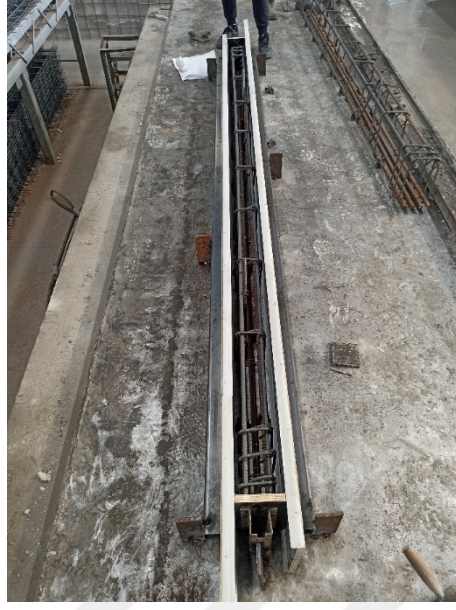
Şekil 4.4 Beton dökümüne hazır deney elemanları (Kişisel arşiv, 2023)
