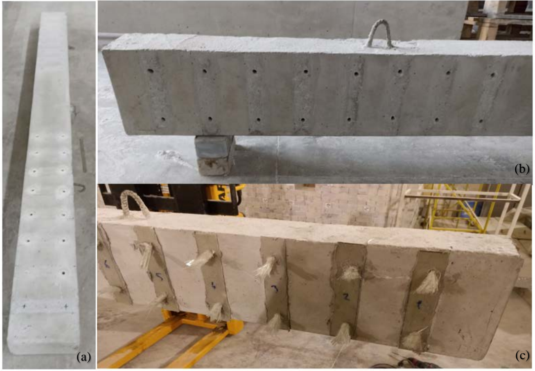
Şekil 4.9 Ankraj deliklerinin açılması (a), ankraj deliklerinin temizlenmesi (b), fan tipi ankraj yöntemiyle betonarme kirişlerin güçlendirilmesi (c) (Kişisel arşiv, 2023)
