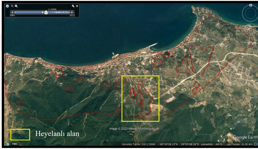
Şekil 4.14. 2006 yılına ait bu görüntüde aktif olan heyelanlı alanlarda yol yapım çalışması öncesi
