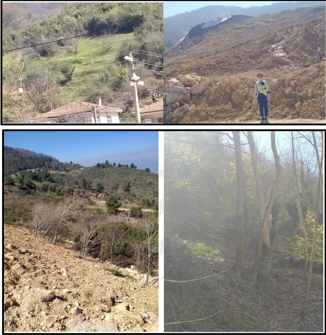
Şekil 2.3. (Devam) İnceleme alanından arazi fotoğrafları
