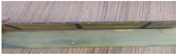
Şeki 4.19: Pompa Paletlerindeki Aşınma.
