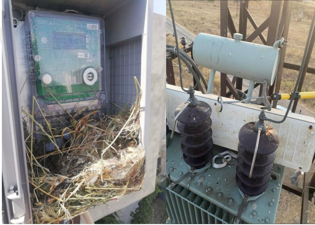
Şekil 3.14. Hayvan kaynaklı oluşan arızalar
