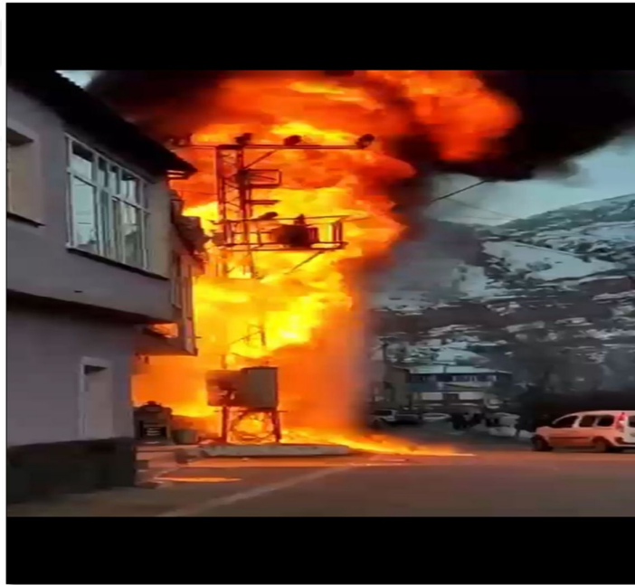
Şekil 3.2. Trafo Alev Alması
