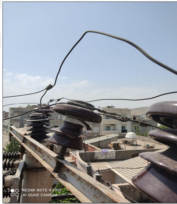
Şekil 3.6. İzolatör Kırılması
