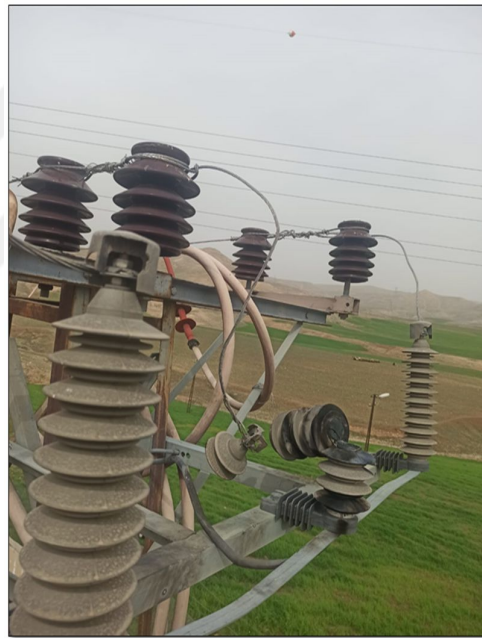
Şekil 3.7. Parafudr patlaması
