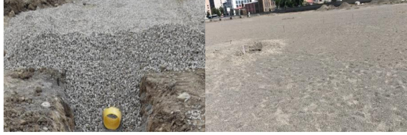
Şekil 4.13. Kars şehir stadı drenaj inşaatından görüntüler
