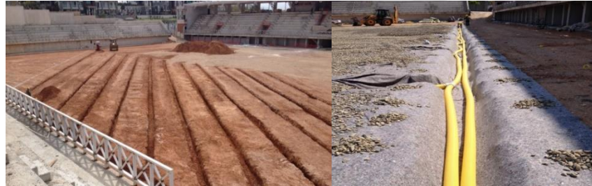
Şekil 1.7. İnşaat sektöründe spor sahalarında drenaj uygulamaları
