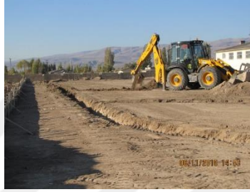
Şekil 4.26. Diyadin ilçe stadı drenaj kanalları kazısından bir görüntü
