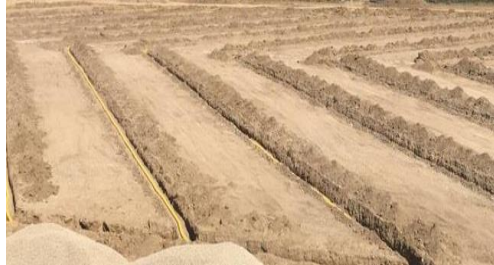
Şekil 4.40. Posof ilçe stadı drenaj çalışmalarından bir görüntü
