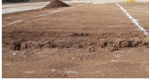
Şekil 4.34. Tutak ilçe stadı drenaj inşaatından bir görüntü
