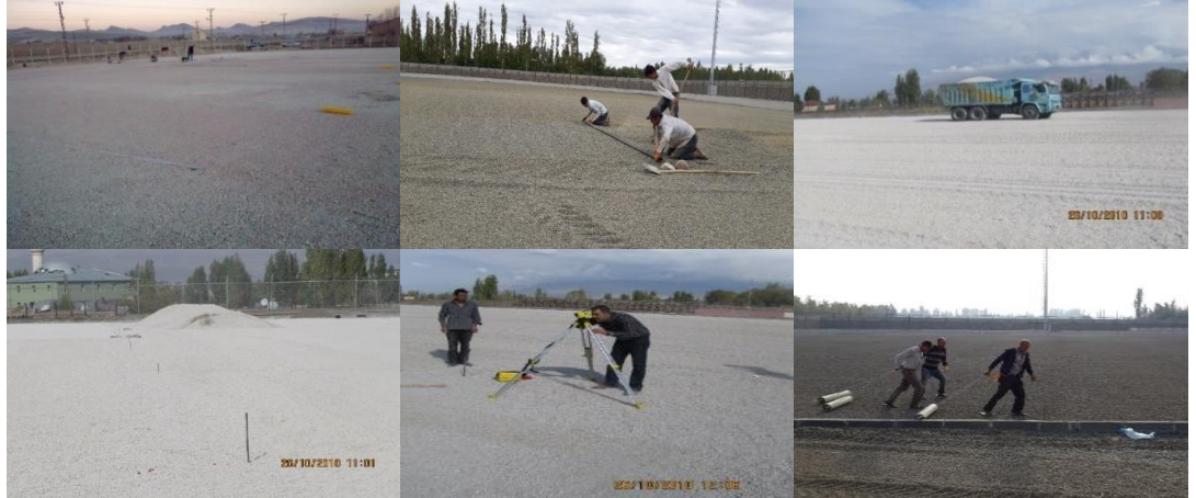
Şekil 1.20. Üst drenaj tabakaları uygulaması
