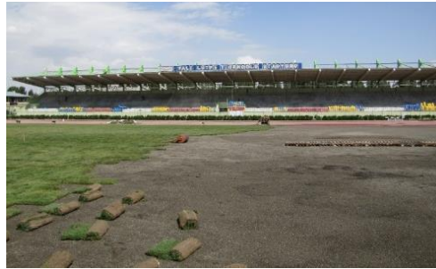
Şekil 4.21. Vali Lütfi Yiğenoğlu Stadyumu üst tabaka drenaj ve çimlendirme çalışması
