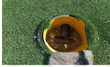
Şekil 4.15. Drenaj başlangıç rögarından bir görüntü
