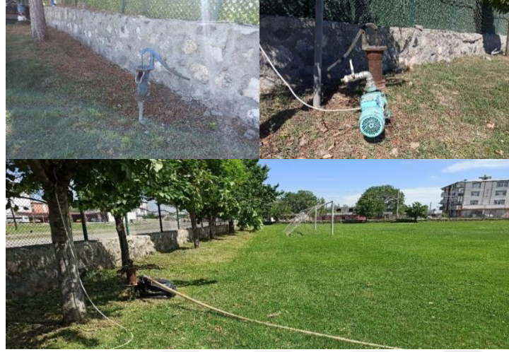
Şekil 4.7. Iğdır Belediyesi semt sahası sulama sistemi (emme basma tulumbalar)
