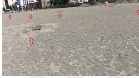
Şekil 4.1. Kars şehir stadı sulama sistemi döşeme safhası (Fıskiye yerleri işaretlenmiştir.)
