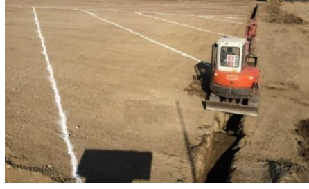
Şekil 4.37. Halilefendi mahallesi 2 no’lu semt sahası drenaj çalışmasından bir görüntü
