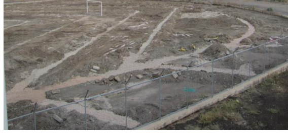
Şekil 4.24. Fırat mahallesi semt sahası drenaj uygulamasından bir görüntü
