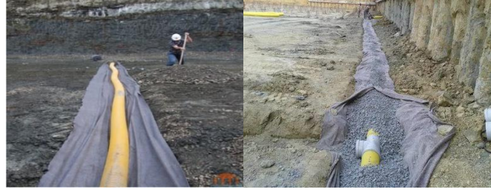
Şekil 1.19. Jeotekstil keçe uygulaması
