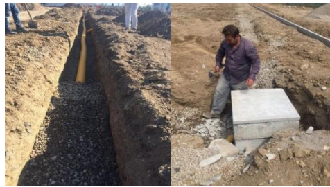
Şekil 4.29. Eleşkirt ilçe stadı drenaj inşaatından görüntüler
