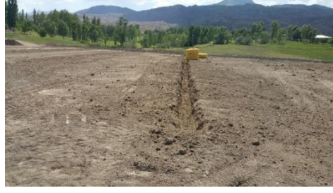
Şekil 4.49. Tuzluca ilçe stadı drenaj inşaatından bir görüntü
