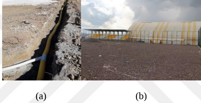
Şekil 4.36. Halilefendi mahallesi 1 no'lu semt sahası drenaj çalışmalarından görüntüler; (a) Kılçık drenaj kanalı, (b) Mıcır drenaj katmanları
