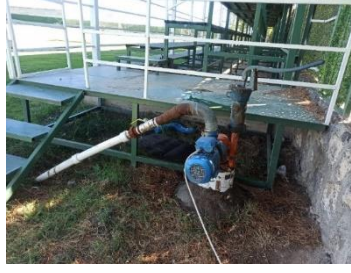
Şekil 4.5. Iğdır belediyesi semt sahası sulama sistemi (sondaj kuyusu üstü hidrofor)
