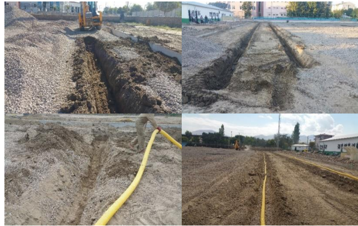
Şekil 4.44. Atatürk mahallesi semt sahası drenaj çalışmalarından görüntüler
