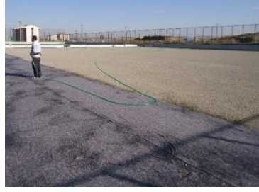
Şekil 1.21. Jeotekstil keçe serme uygulaması
