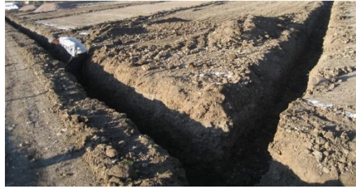
Şekil 4.20. Selim ilçe stadı kılçık kanal drenaj sisteminden bir görüntü
