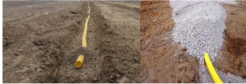
Şekil 1.18. (a) Drenaj kanalı (b) Mıcır dolgusu
