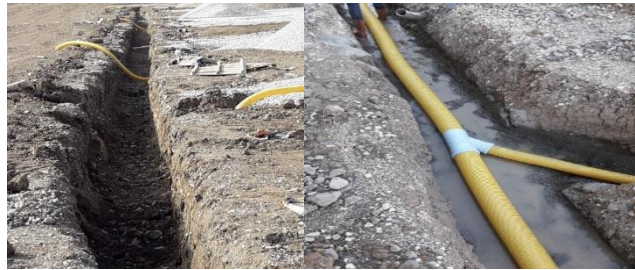
Şekil 4.16. Kağızman ilçe stadı drenaj inşaatından görüntüler
