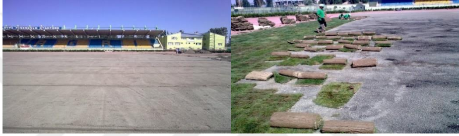
Şekil 1.24. Doğal çim saha drenaj ve çim serme uygulaması
