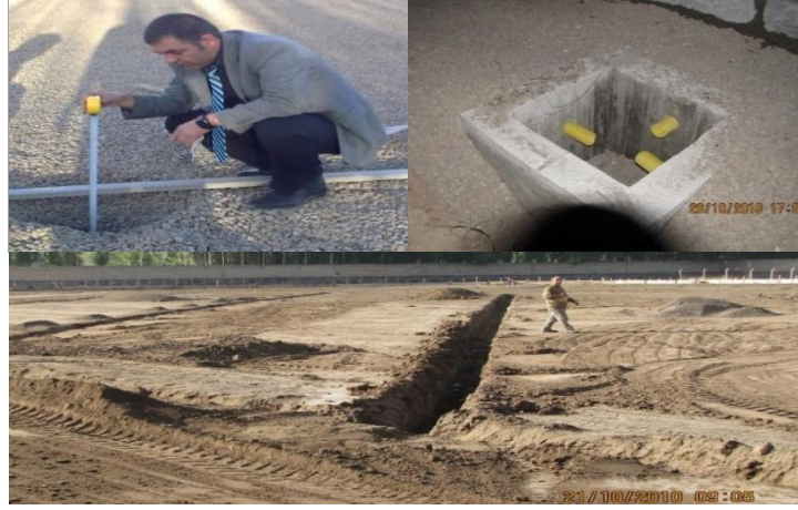
Şekil 4.31. Patnos ilçe stadı drenaj sistemi yapım aşamalarından görüntüler
