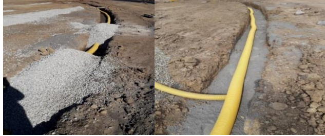
Şekil 4.25. İbrahim Çeçen Üniversitesi stadı drenaj uygulamasından görüntüler
