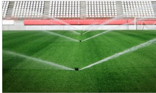
Şekil 1.6. Mantar sprink modeli sulama uygulaması
