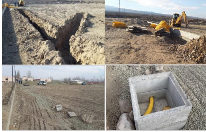
Şekil 4.48. Halfeli beldesi stadı drenaj inşaatından görüntüler
