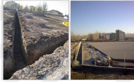
Şekil 4.33. Taşlıçay ilçe stadı drenaj sistemi yapım çalışmalarından görüntüler
