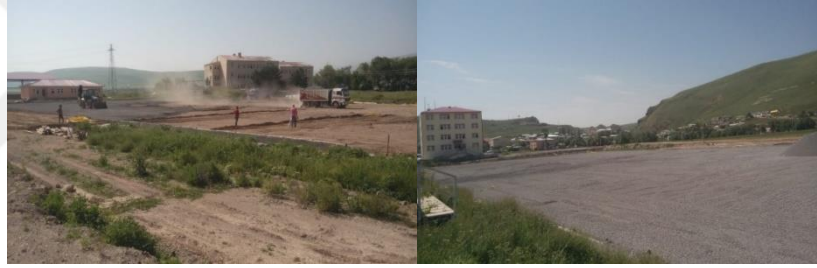
Şekil 4.38. Çıldır ilçe stadı drenaj çalışmalarından görüntüler
