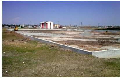
Şekil 4.14. Kars Halitpaşa mahallesi semt sahası drenaj inşaatından bir görüntü
