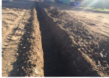
Şekil 4.30. Hamur ilçe stadı drenaj kanalı kazısından bir görüntü
