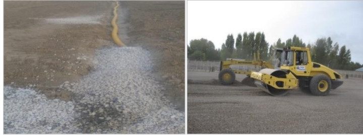
Şekil 4.32. Patnos gençlik merkezi sahası drenaj sistemi yapım aşamasından görüntüler
