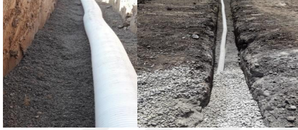
Şekil 4.17. Sarıkamış ilçe stadı kılçık kanal drenaj uygulamasından görüntüler
