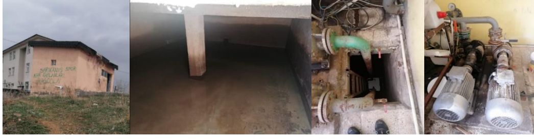
Şekil 4.3. Sarıkamış antrenman sahası su deposu ve pompa istasyonundan görüntüler (a) Depo dış görünüşü (b) Depo iç görünüşü (c) Emiş boruları (d) Hidrofor dinamları
