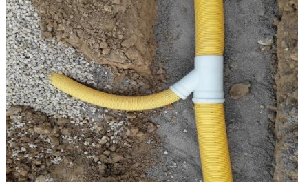
Şekil 4.56. Uygun çaplarda seçilmiş ana ve kılçık drenaj boruları
