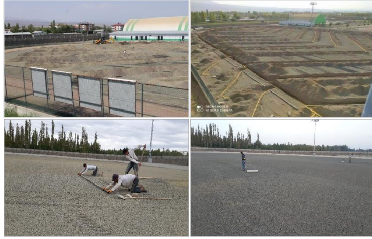
Şekil 4.43. Karaağaç mahallesi futbol sahası drenaj çalışmalarından görüntüler
