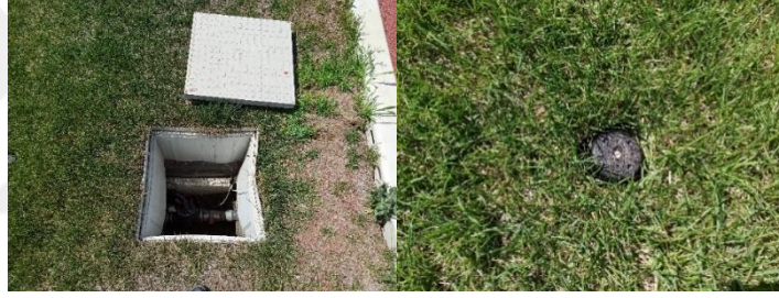
Şekil 4.1. Kars şehir stadı sulama sistemi döşeme safhası (Fıskiye yerleri işaretlenmiştir.)
