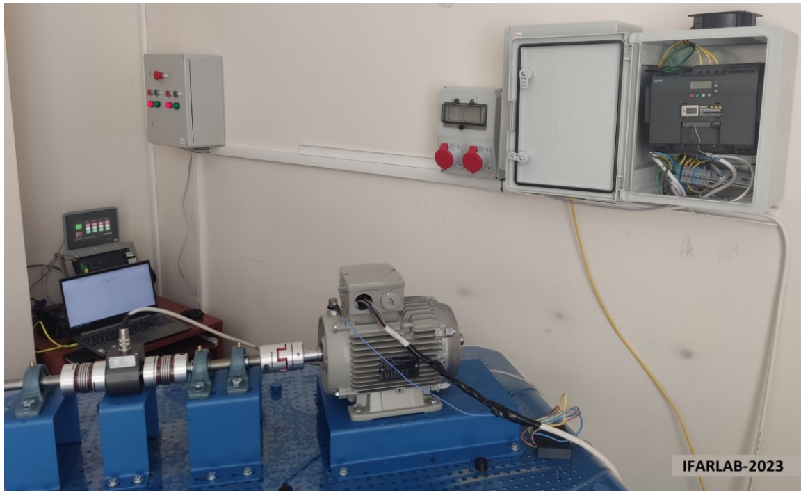
Şekil 3.6. IFARLAB elektrik motoru test düzeneği (IFARLAB,2023).
