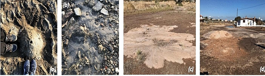
Şekil 3.22 İçmeler ve Gülbahçe ilçesi kıyılarında deprem kaynaklı zemin sivilaşmasının kum kaynaması şeklinde oluşan yüzey belirtileri (a) 38^{\circ}20'18.4''K , 26^{\circ}38'51.0''D , (b) 38^{\circ}18'37.3''K , 26^{\circ}40'47.1''D ve (c-d) 38.338088^{\circ}K , 26.647763^{\circ}D (Ziotopoulou et al., 2022).
