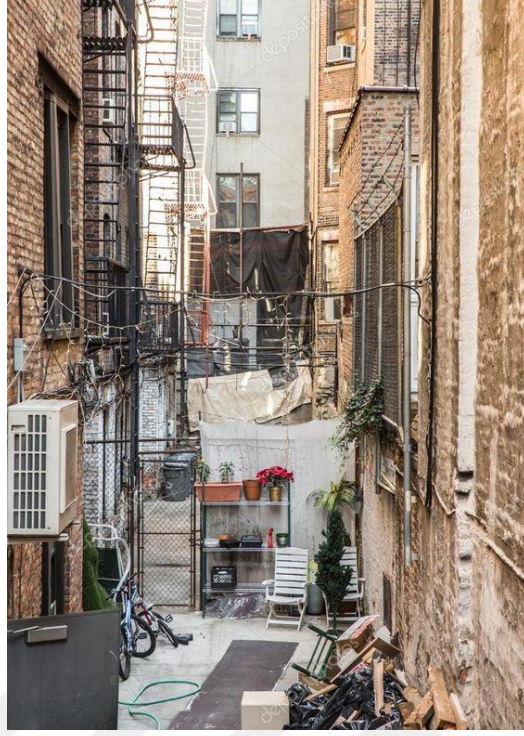
Şekil 4.34. Binalar arası atıl alan (URL-4.17)
