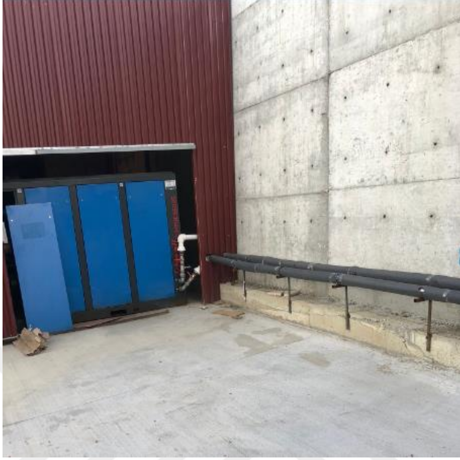
Şekil 4.10. Kompresör yerinin dışarıdan görünümü
