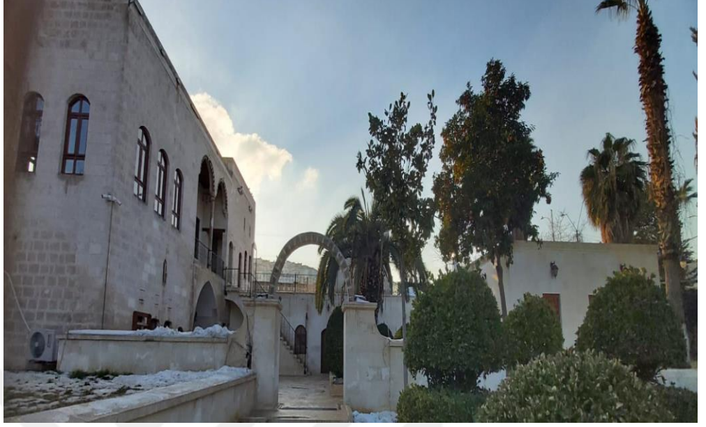
Ek-7: Haleplibahçe Mahallesi'nde bulunan Sâkıb Efendi Köşkü'nün genel görünümü.
