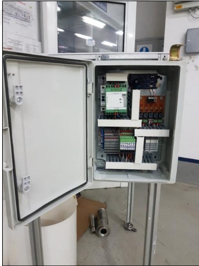
Şekil 4.13. Pano montajı
