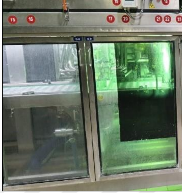
Şekil 3.9. Dolum-UV-yapıştırma ve kesme üniteleri
