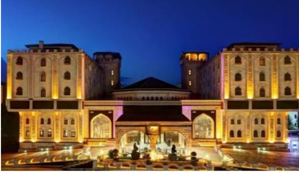
Şekil 23. Otel işlevi olan iskelet yapı örneği, Avanos [19].
