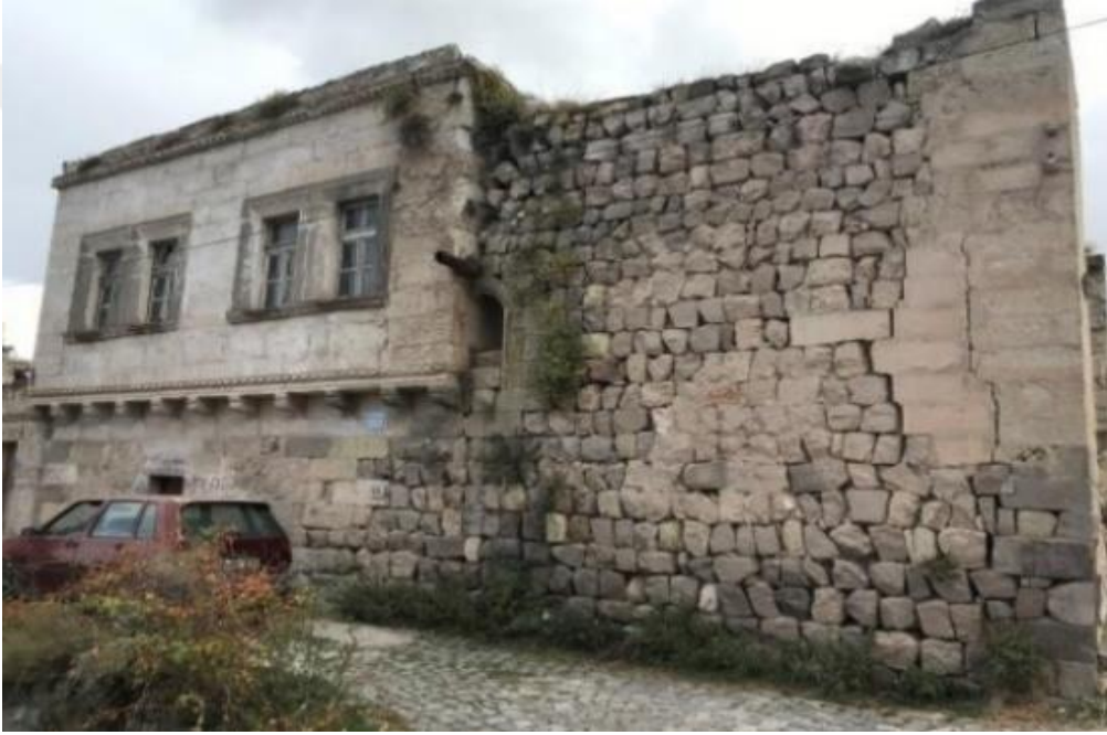
Şekil 22. Yığma yapı, Uçhisar [29].
