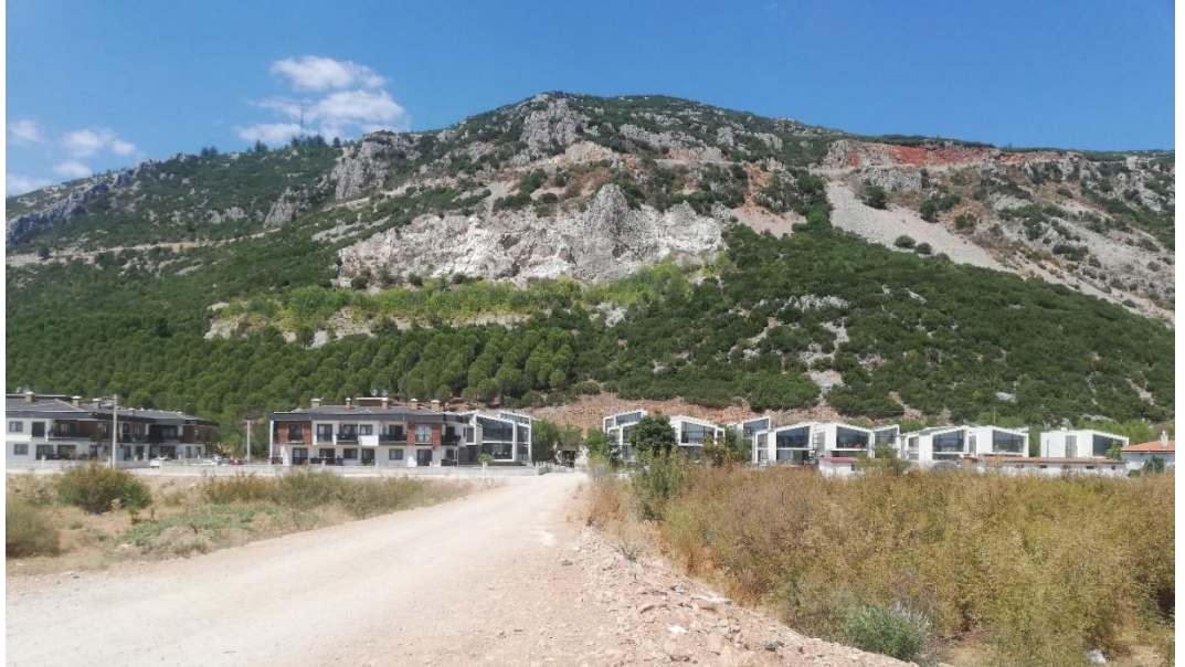
Foto 16: Düğerek girişinde inşa edilen yeni tip konutlar
