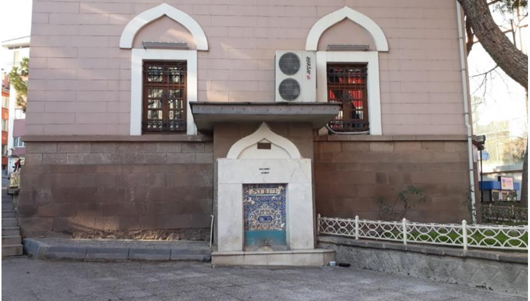
Hacı Ali Camii Duvarı
