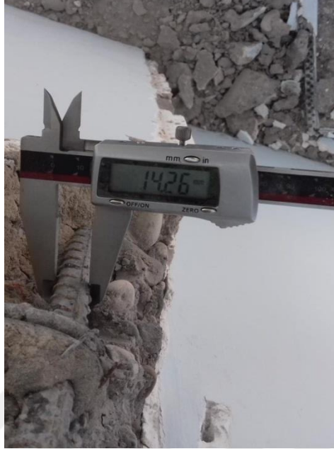
Şekil 4.5 Stırırma İşlemi Yapıldıktan Sonra Donatı Ölçümü
