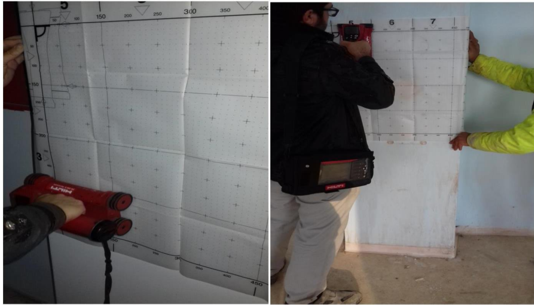
Şekil 4.4 Donatı Tespitinin Yapılması
