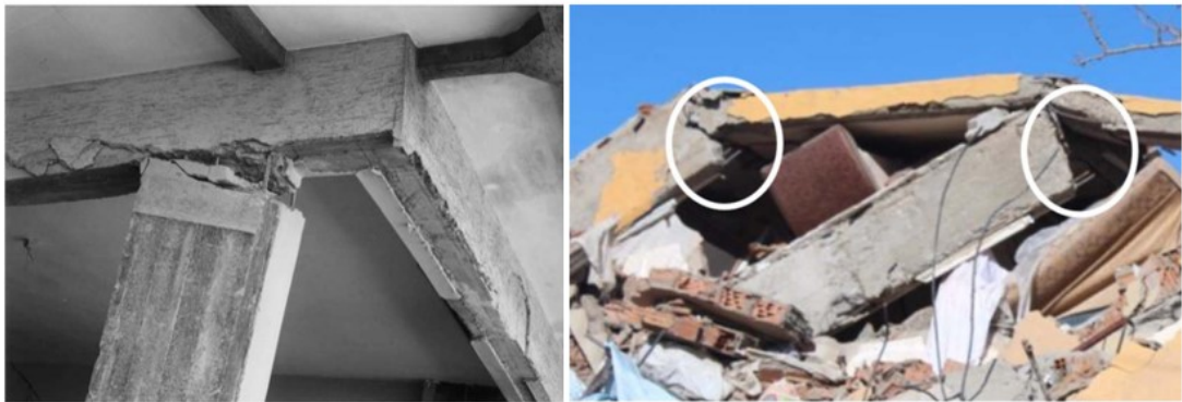
Şekil 1.2 : Boyuna donatı sıyrılmalarına örnekler: 1999 Kocaeli (Bruneau, 2002), 2020 Sivrice (Mertol ve diğ, 2021).
