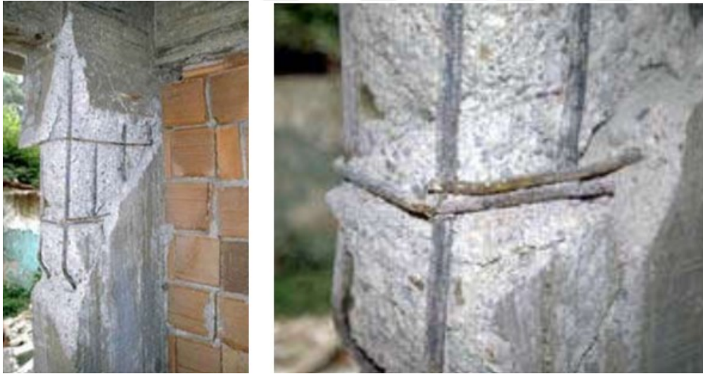
Şekil 1.5 : Geniş dikdörtgen bir kolonun hasar görüntüsü ve enine donatı detayı (Sezen ve diğ, 2000).
