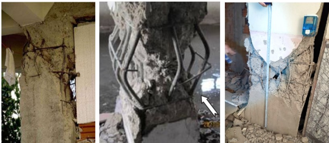
Şekil 1.1 : Yetersiz enine donatı örnekleri: 1999 Kocaeli (Sezen ve diğ, 2000), 2011 Van (Murat, 2015), 2020 İzmir (Yakut ve diğ, 2021).
