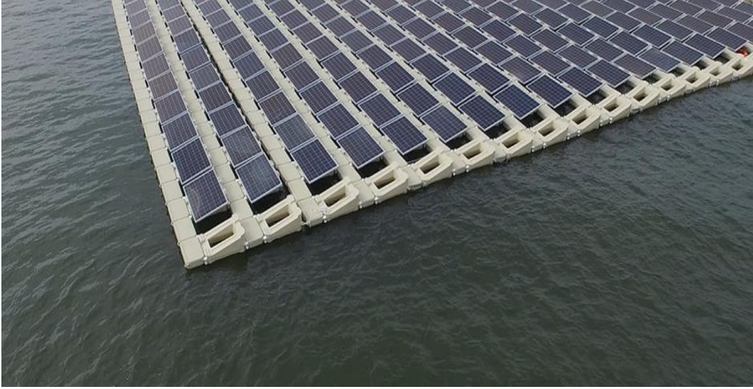
Şekil 2.12.Gerçek bir yüzer fotovoltaik sistemden yüzdürücü sistem tasarımı örneği [2]
