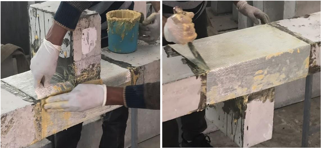
Şekil 3.21. GFRP kumaşın kirişe uygulanması
