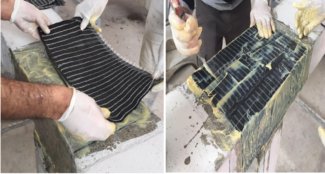
Şekil 3.20. CFRP kumaşın kirişe uygulanması
