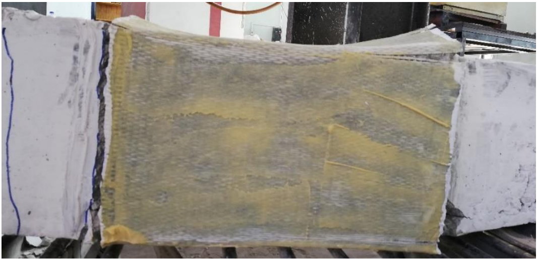
Şekil 4.50. SB-GFRP deney elemanının göçme anındaki görüntüsü
