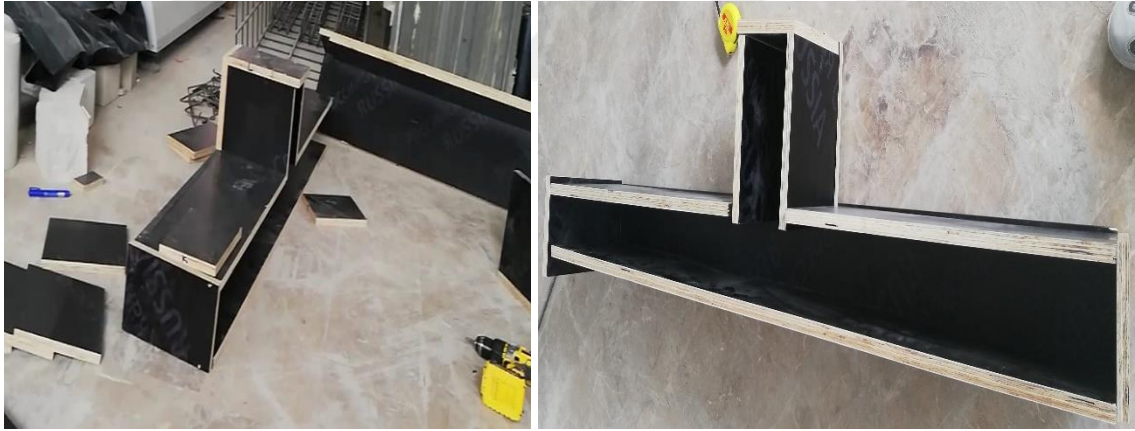
Şekil 3.15. Kalıpların hazırlanması
