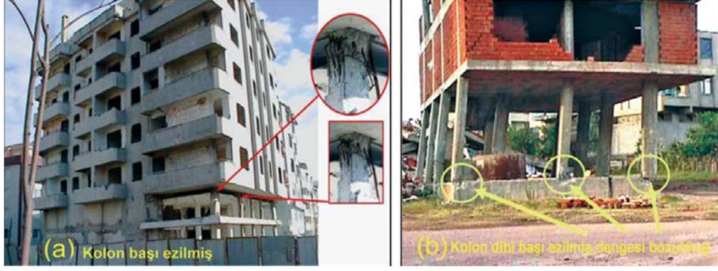
(a) Kısa kolonda başları ezilmiş bina başlı ezilmiş dengersiz bina (KAPLAN, 2010)
