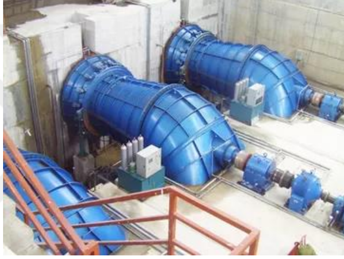
{Şekil 2.16 Boru Tipi Türbin (URL 9)}
