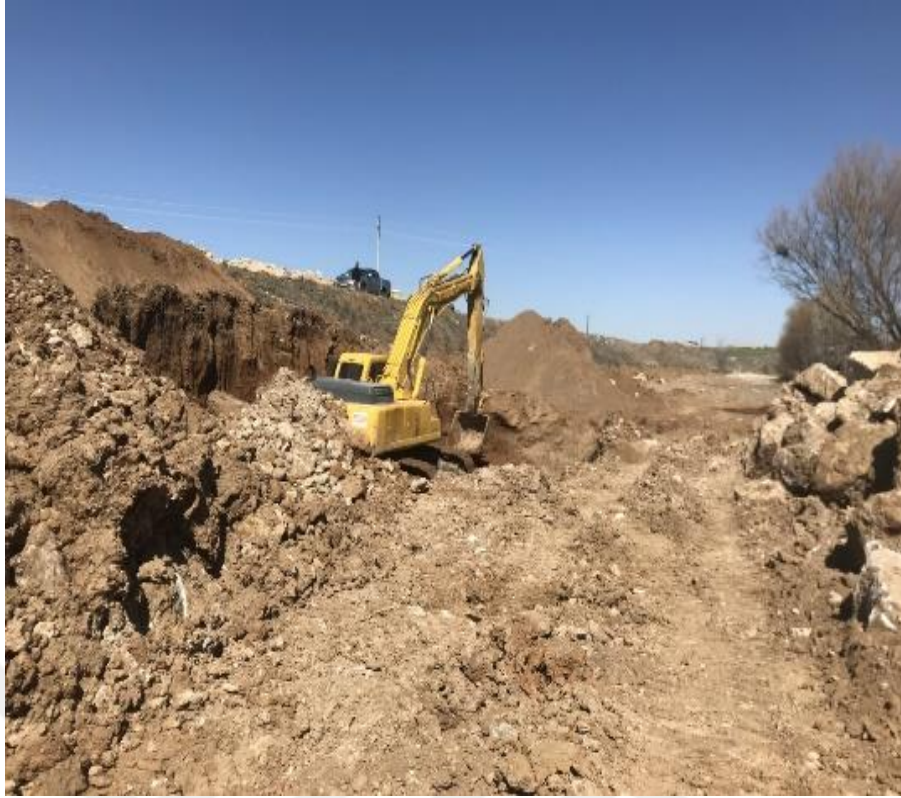
Şekil 4.22. Obruk kapatma çalışmaları
