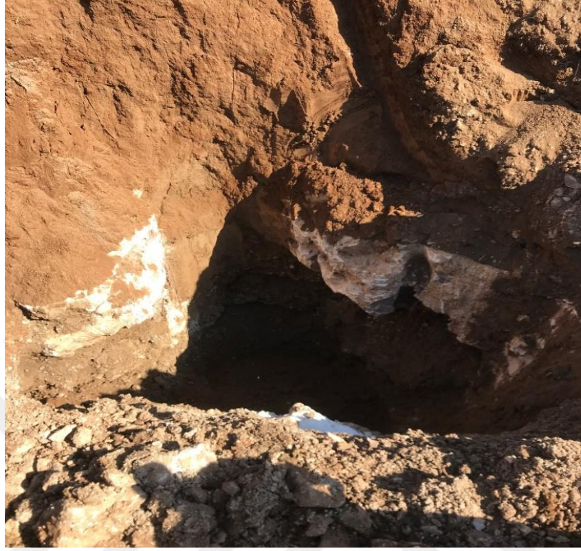
Şekil 4.20. Toprak kanalda oluşan obruklar
