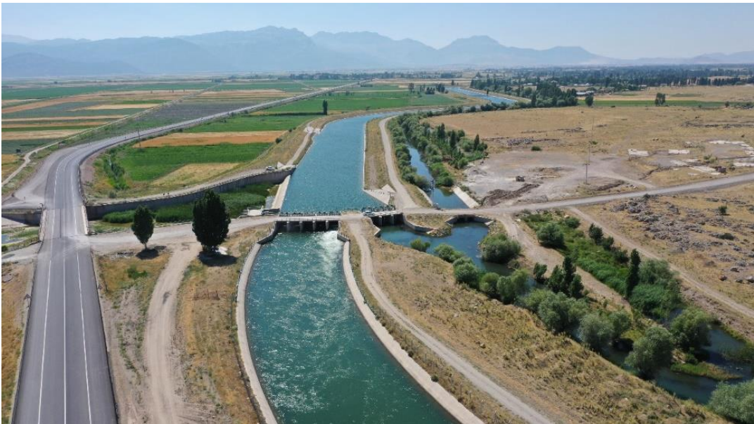
Şekil 2.9. BSA kanalı (DSİ, 2021)
