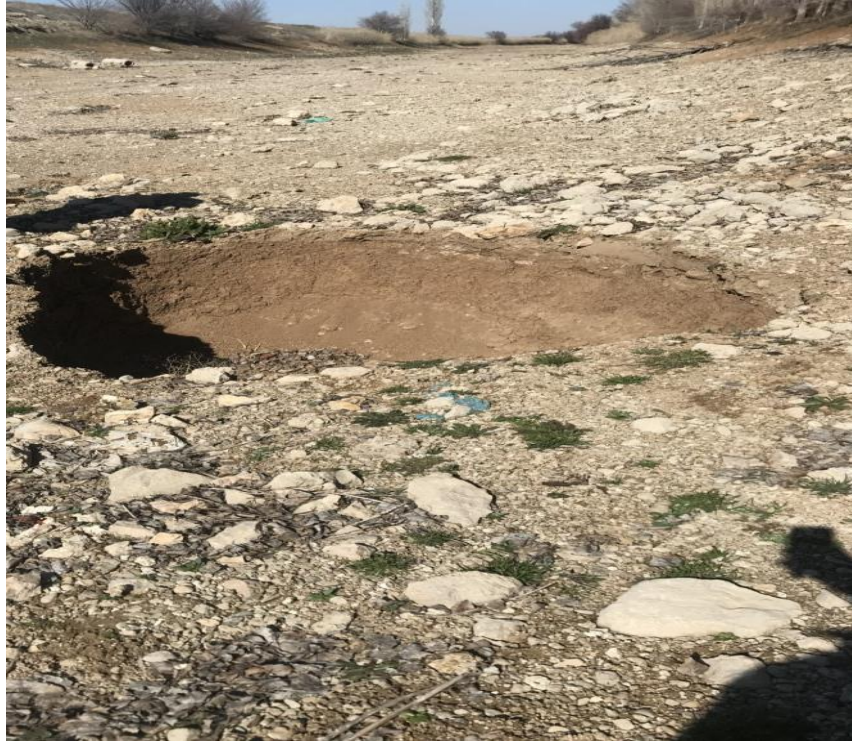
Şekil 4.21. Toprak kanalda oluşan obruklar
