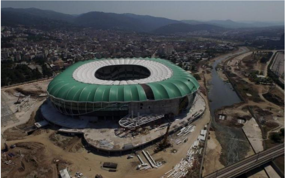
Şekil 5.34: Timsah Arena Stadyumu inşaatı ve Nilüfer Çayı (Url-14)
