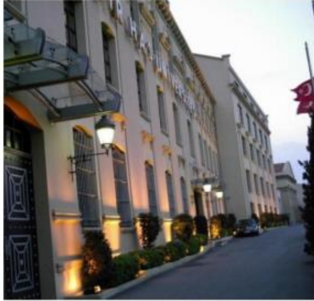
Resim 49.Kadir Has Üniversitesi cephe görünüşü (Önder Yılmaz, 2020)
