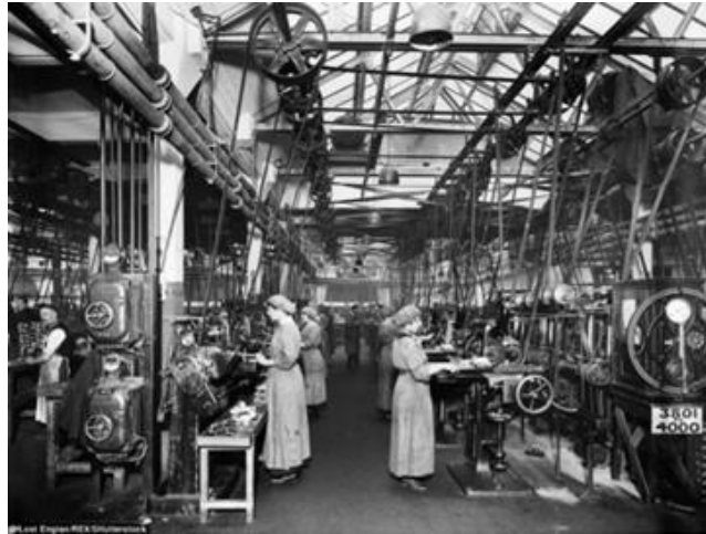
Resim 4.Çatıda çelik konstrüksiyon kullanılmış bir fabrika iç mekanı (URL-1)
