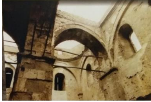
Resim 7.Lengerhane yapısının restorasyondan önceki hali (URL-4)
