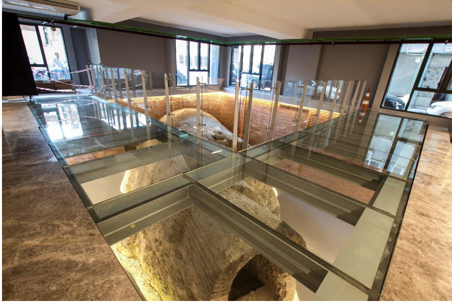
Resim 54.1020 ada 13 parseldeki su dolabının yapıya katılması için oluşturulan cam döşeme (Alper, 2018)
