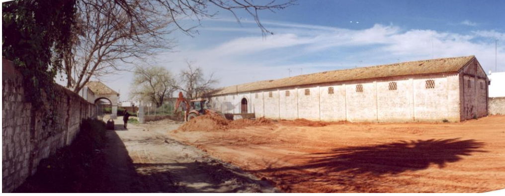
Resim 13.halk kütüphanesi olarak yeniden kullanılan Almonte'deki eski şarap mahzeninin işlevlendirmeden önceki durumu (URL-8)
