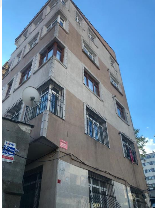
Resim 43.Yenileme Alanı Sınır Dışında Kalan Betonarme Yapı Örneği, Haydar Cad. (Önder Yılmaz, 2020)
