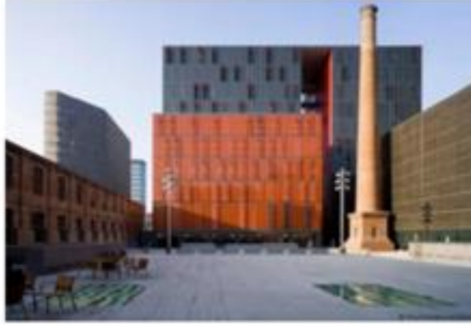
Resim 16.İletişim fakültesine döndürülen eski tekstil fabrikası Ca L'aranyo, eski fabrika yapıları ve modern çağdaş mimari yapılar (URL-9)
