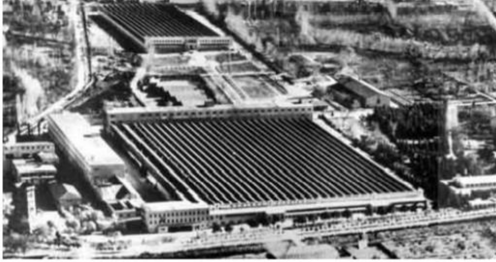
Resim 30.Yapının eski görünümü. (URL-15)
