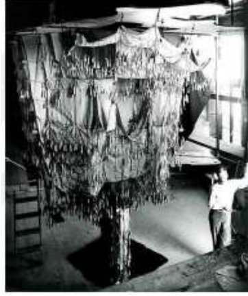
Şekil 2.14. Gaudi'nin Colonia Güell için asılı modeli
