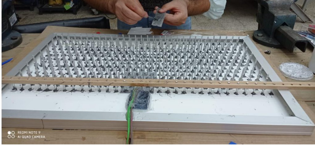
Şekil 6.2. Silindirik kanatçıkların panele yapıştırılması
