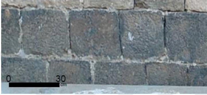
Şekil 5.7 Birca Belek'in ilk sıralarında bazaltta meydana gelen kahverengi birikintiler(soiling)
