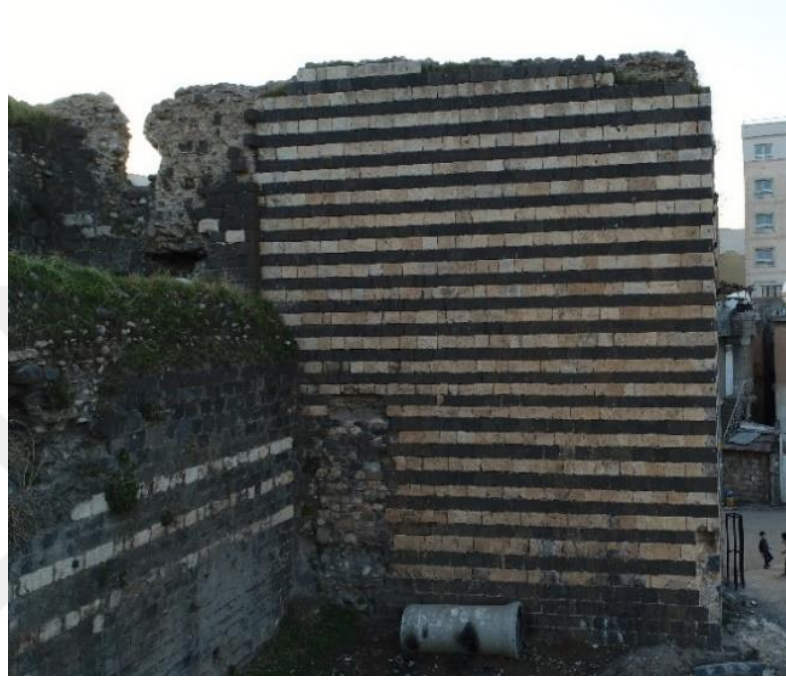
Şekil 4.17 Birca Belek güneye bakan cephesi
