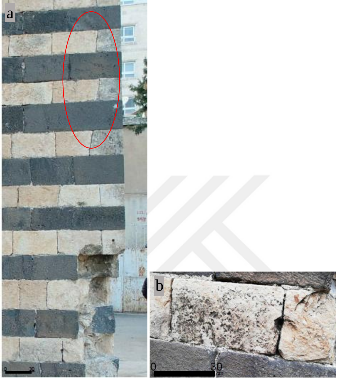
Şekil 5.5 Birca Belek'te gözlenen siyah kabuklaşma (black crust) bozunma türü
