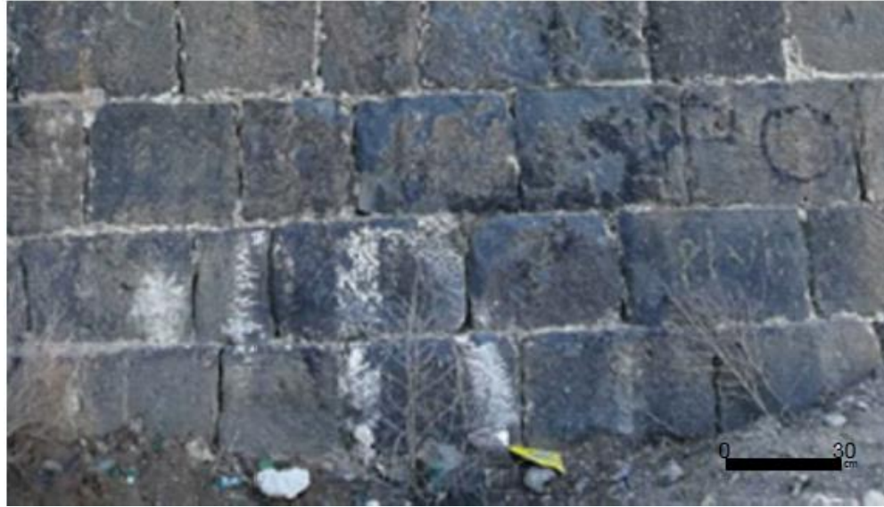
Şekil 5.8 Birca Belek'te görülen yazılama (graffiti) bozunma türü
