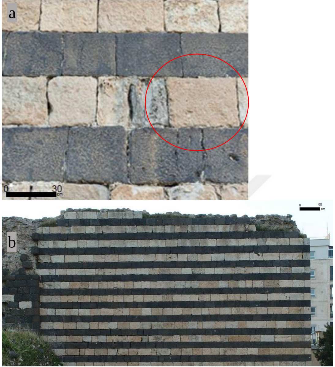
Şekil 5.6 Birca Belek’te gözlemlenen renk değişimi (bleaching) bozunma türünün dağılımı
