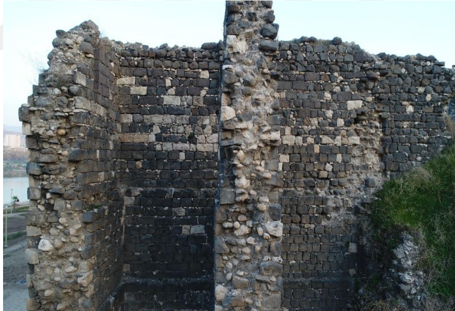
Şekil 4.24 Birca Belek iç kısım duvar yaprağında duvar kalınlığında yapılan daralmalar üst kısım
