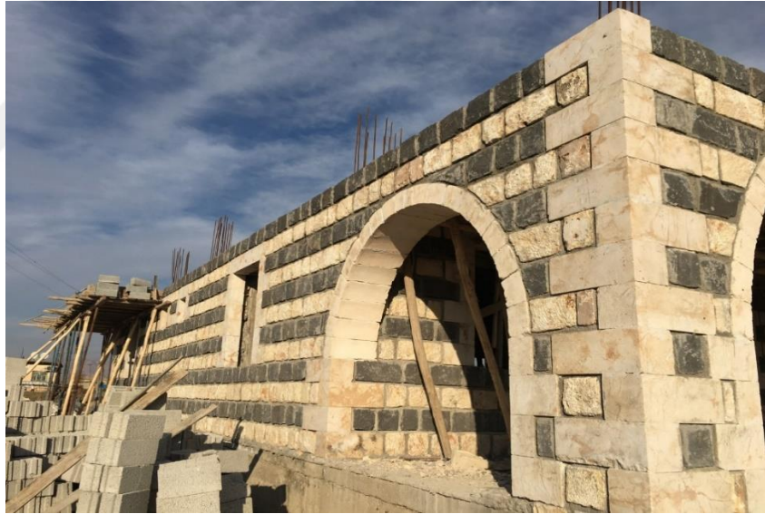
Şekil 4.33 2. Lokasyondan alınan taşlardan yeni yapılan bir yapı
