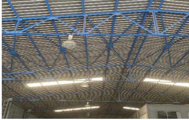
Şekil 4.64. 14 Nolu Örnek Sanayi Yapısı İç Görünüşü
