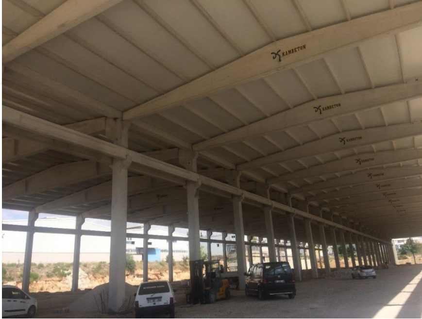
Şekil 4.57. 12 Nolu Örnek Sanayi Yapısı İç Görünüşü
