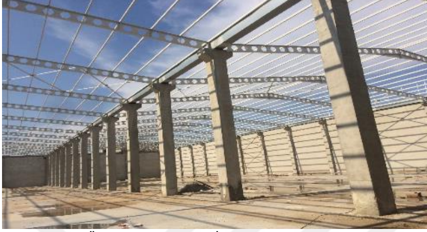
Şekil 4.47. 10 Nolu Örnek Sanayi Yapısı İç Görünüşü
