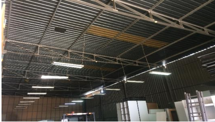
Şekil 4.16. 4 Nolu Örnek Sanayi Yapısı İç Görünüşü
