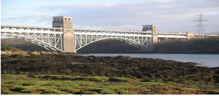
Şekil 3.26. Britannia köprüsü, İngiltere (Url- 28)
