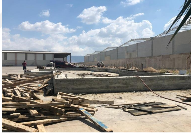
Şekil 4.27. 7 Nolu Örnek Sanayi Yapısı Yapım Aşamaları- Temelin bitmiş hali
