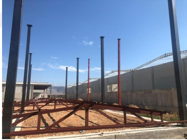
Şekil 4.29. 7 Nolu Örnek Sanayi Yapısı Yapım Aşamaları- Kolon aplikasyonu
