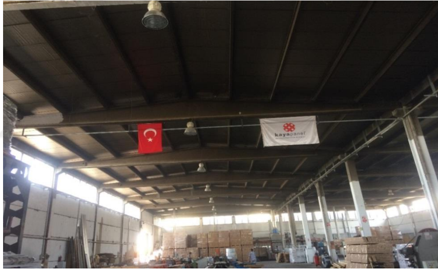
Şekil 4.9. 3 Nolu Örnek Sanayi Yapısı İç Görünüşü
