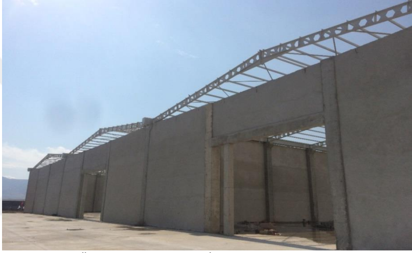
Şekil 4.45. 10 Nolu Örnek Sanayi Yapısı İç Görünüşü
