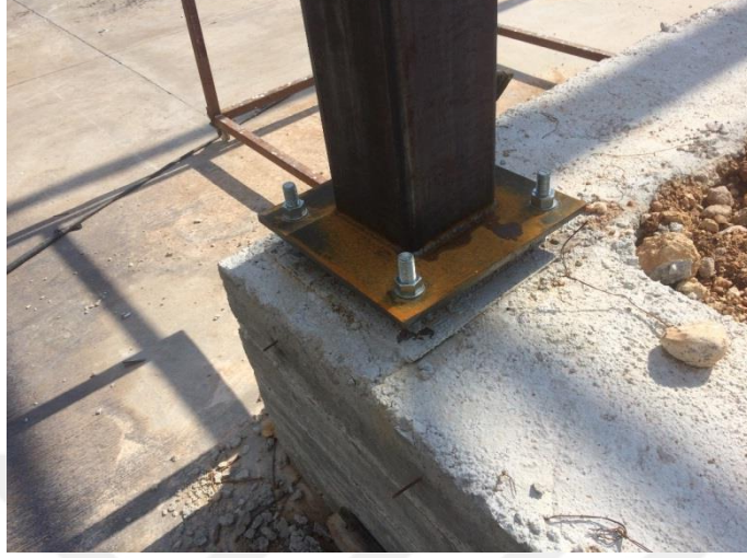
Şekil 4.28. 7 Nolu Örnek Sanayi Yapısı Yapım Aşamaları-Kolon ayağının temele montesi
