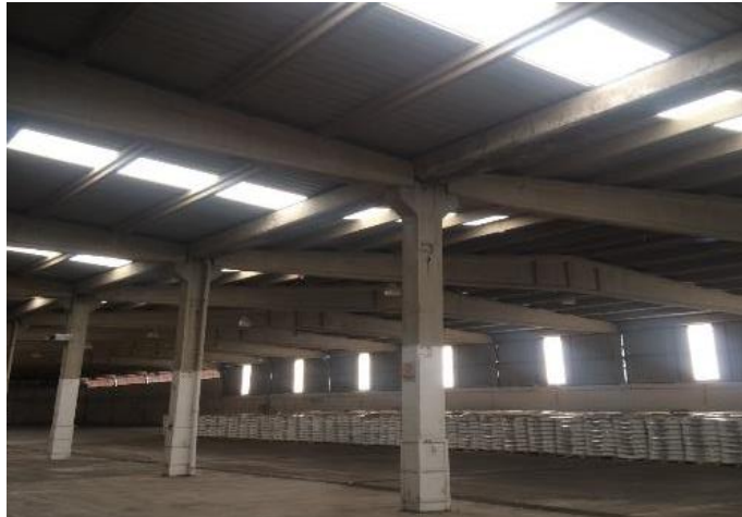
Şekil 4.42. 9 Nolu Örnek Sanayi Yapısı İç Görünüşü
