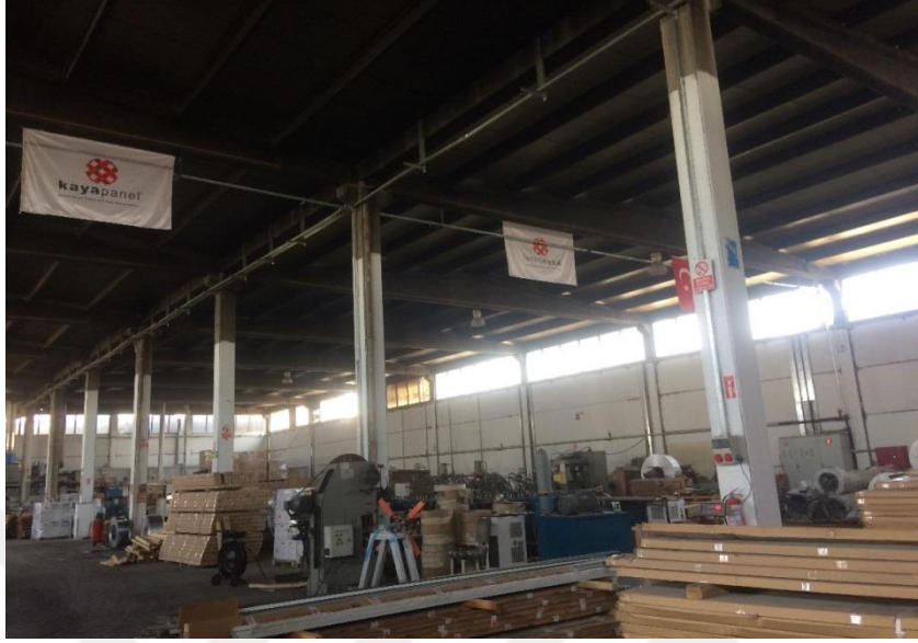
Şekil 4.10. 3 Nolu Örnek Sanayi Yapısı İç Görünüşü
