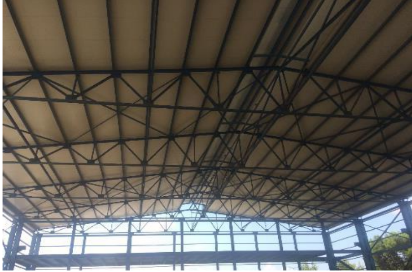
Şekil 4.60. 13 Nolu Örnek Sanayi Yapısı İç Görünüşü
