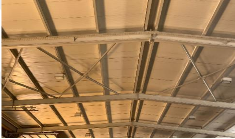
Şekil 4.24. 6 Nolu Örnek Sanayi Yapısı Çatı Görünüşü
