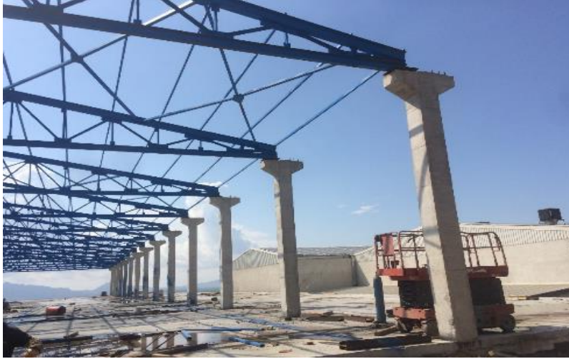
Şekil 4.51. 11 Nolu Örnek Sanayi Yapısı İç Görünüşü
