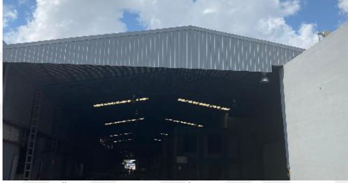
Şekil 4.63. 14 Nolu Örnek Sanayi Yapısı İç Görünüşü
