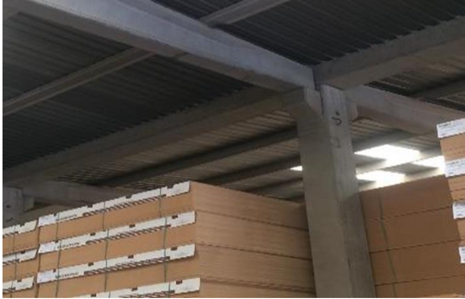
Şekil 4.3. 1 Nolu Örnek Sanayi Yapısı İç Görünüşleri
