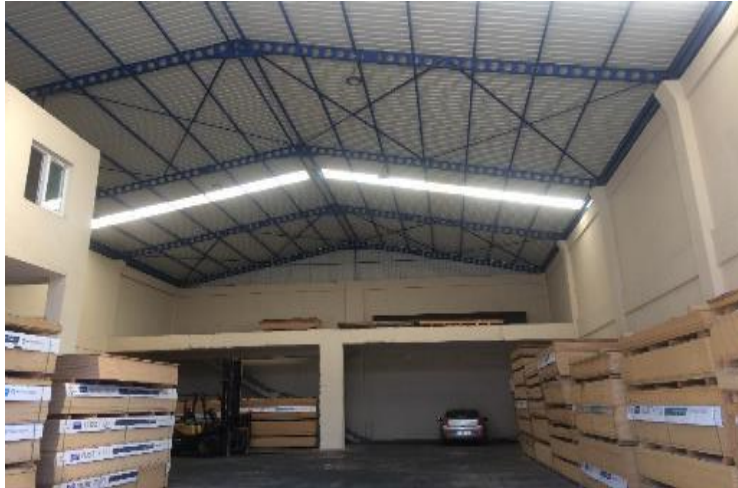
Şekil 4.6. 2 Nolu Örnek Sanayi Yapısı İç Görünüşü
