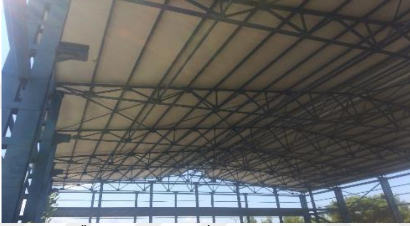
Şekil 4.59. 13 Nolu Örnek Sanayi Yapısı İç Görünüşü
