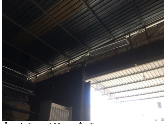
Şekil 4.17. 4 Nolu Örnek Sanayi Yapısı İç Görünüşü
