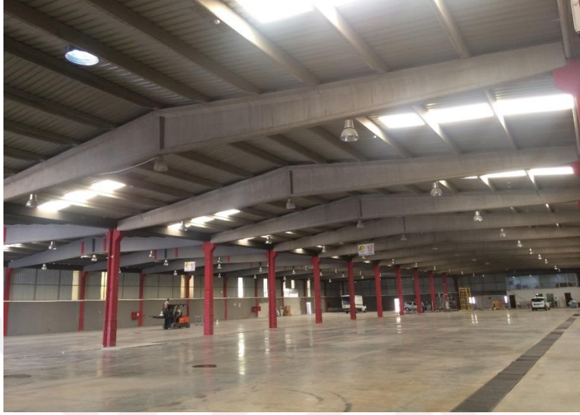
Şekil 4.38. 8 Nolu Örnek Sanayi Yapısı İç Görünüşü
