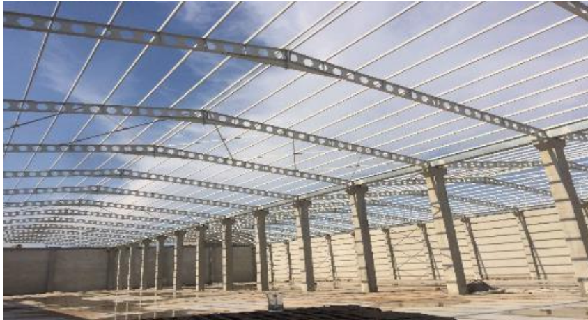
Şekil 4.46. 10 Nolu Örnek Sanayi Yapısı İç Görünüşü
