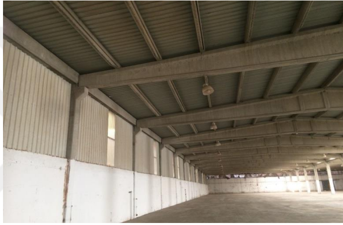
Şekil 4.41. 9 Nolu Örnek Sanayi Yapısı İç Görünüşü
