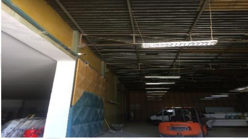
Şekil 4.15. 4 Nolu Örnek Sanayi Yapısı İç Görünüşü
