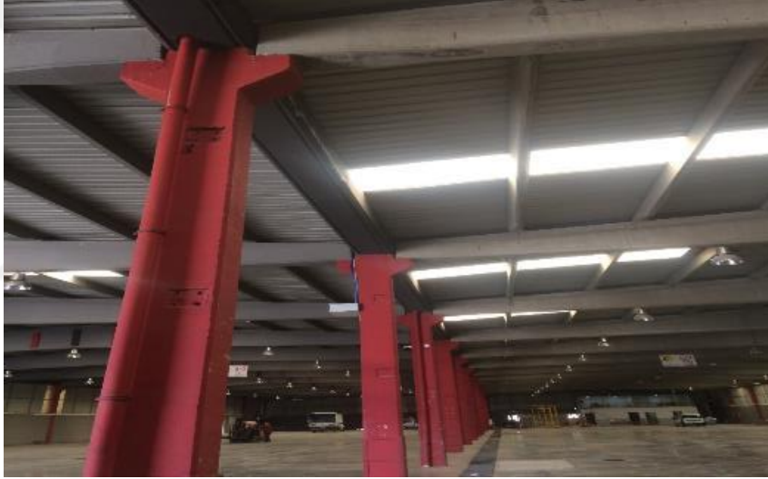
Şekil 4.35. 8 Nolu Örnek Sanayi Yapısı İç Görünüşü
