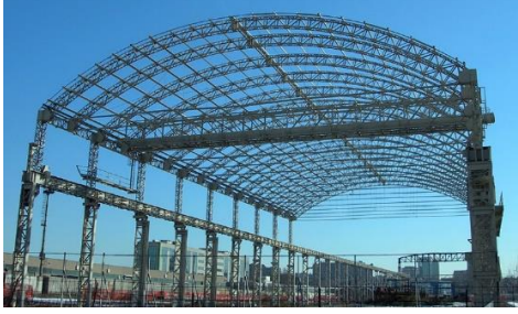
Şekil 3.23. Çelik çerçeve simtemi örneği( Url-25)
