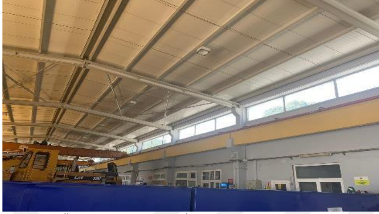
Şekil 4.23. 6 Nolu Örnek Sanayi Yapısı İç Görünüşü
