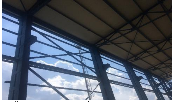
Şekil 4.61. 13 Nolu Örnek Sanayi Yapısı İç Görünüşü
