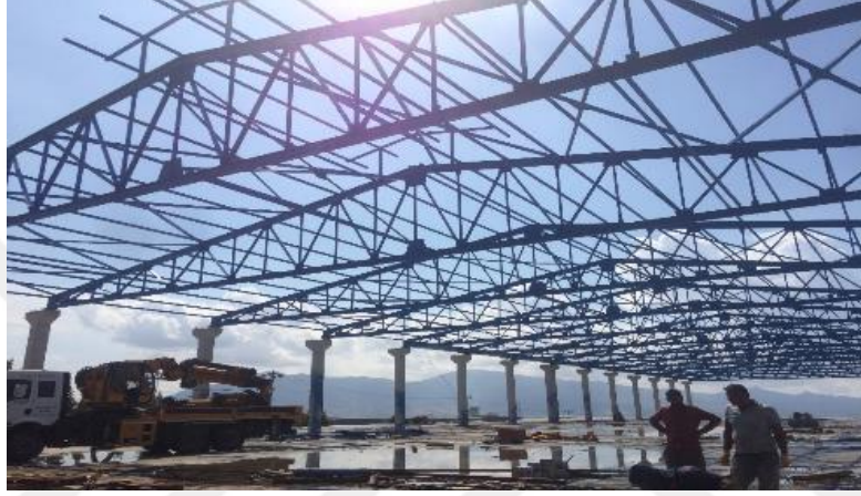
Şekil 4.50. 11 Nolu Örnek Sanayi Yapısı İç Görünüşü
