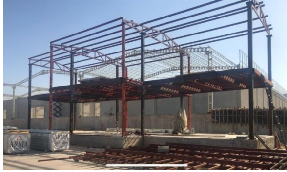
Şekil 4.30. 7 Nolu Örnek Sanayi Yapısı Yapım Aşamaları – Kiriş ve döşeme yerleştirilmesi
