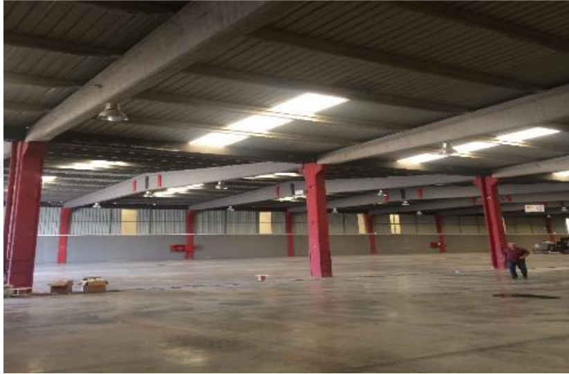
Şekil 4.37. 8 Nolu Örnek Sanayi Yapısı İç Görünüşü
