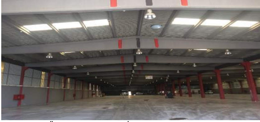
Şekil 4.34. 8 Nolu Örnek Sanayi Yapısı İç Görünüşü
