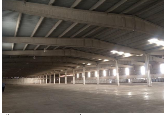
Şekil 4.43. 9 Nolu Örnek Sanayi Yapısı İç Görünüşü
