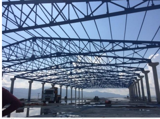
Şekil 4.52. 11 Nolu Örnek Sanayi Yapısı İç Görünüşü
