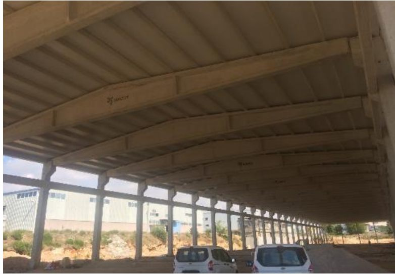
Şekil 4.55. 12 Nolu Örnek Sanayi Yapısı İç Görünüşü
