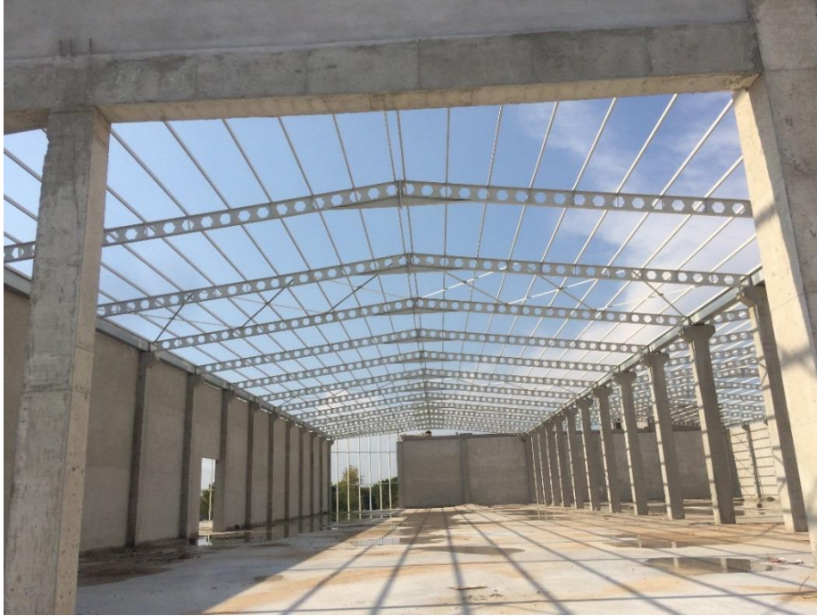
Şekil 4.48. 10 Nolu Örnek Sanayi Yapısı İç Görünüşü
