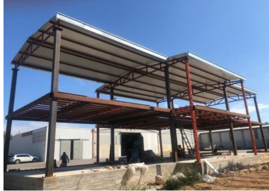
Şekil 4.32. 7 Nolu Örnek Sanayi Yapısı Yapım Aşamaları – Taşıyıcı sistemin bitmiş hali
