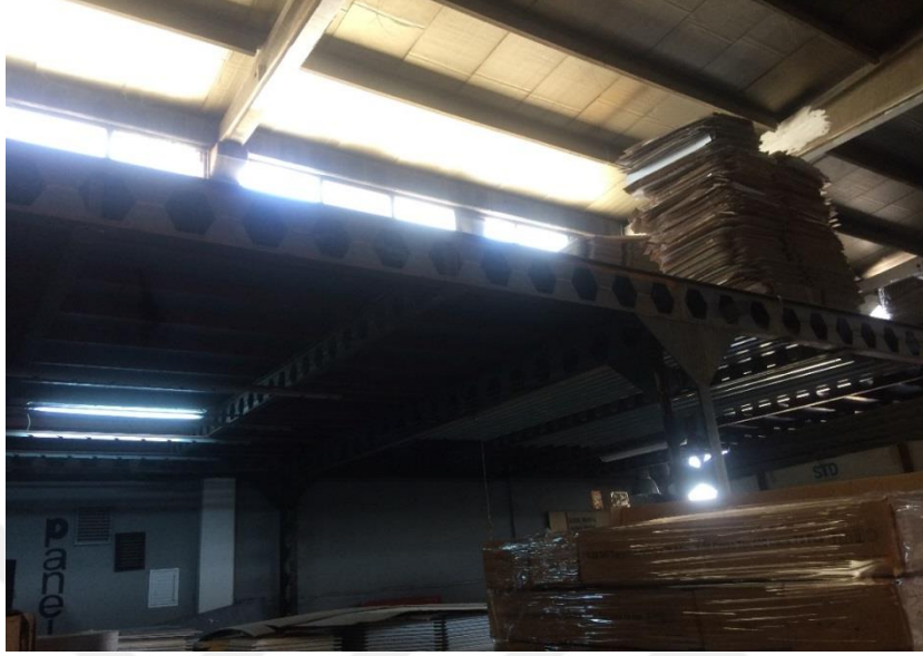
Şekil 4.12. 3 Nolu Örnek Sanayi Yapısı İç Görünüşü
