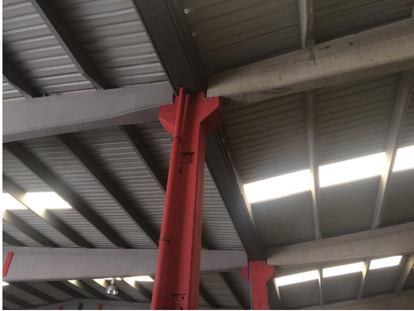
Şekil 4.39. 8 Nolu Örnek Sanayi Yapısı İç Görünüşü
