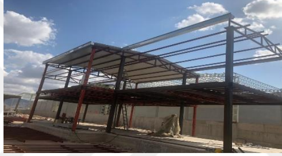
Şekil 4.31. 7 Nolu Örnek Sanayi Yapısı Yapım Aşamaları- Çatı kaplama aşaması
