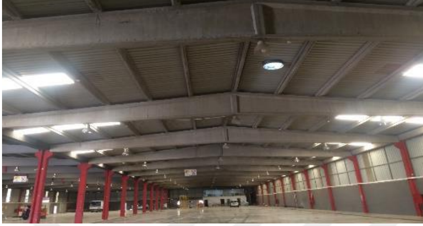
Şekil 4.36. 8 Nolu Örnek Sanayi Yapısı İç Görünüşü
