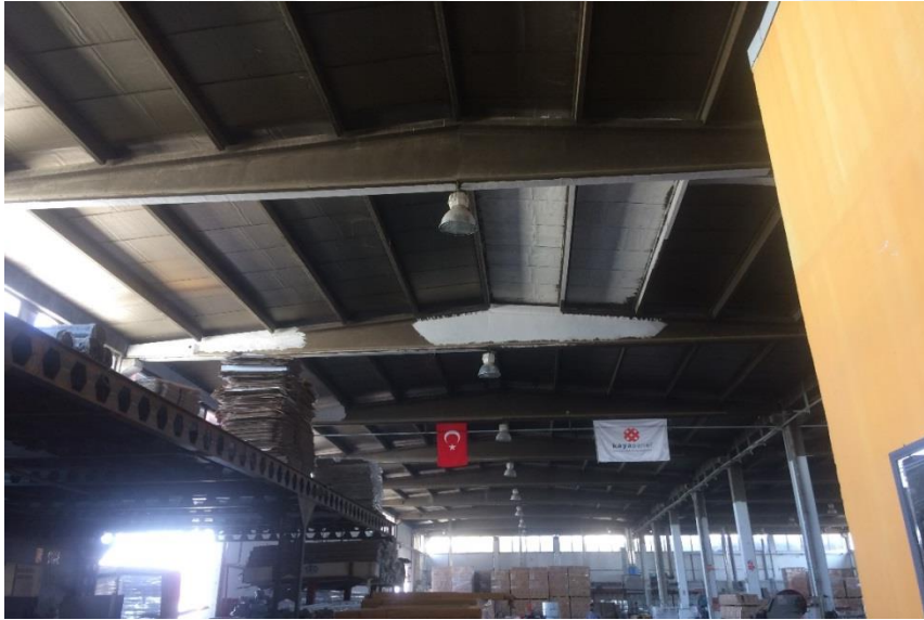
Şekil 4.11. 3 Nolu Örnek Sanayi Yapısı İç Görünüşü
