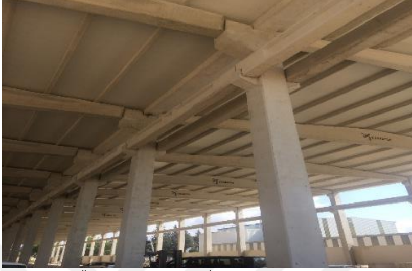
Şekil 4.56. 12 Nolu Örnek Sanayi Yapısı İç Görünüşü
