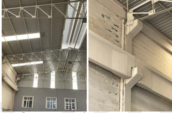
Şekil 4.20. 5 Nolu Örnek Sanayi Yapısı İç Görünüşleri
