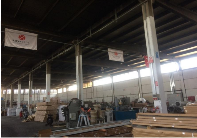
Şekil 4.13. 3 Nolu Örnek Sanayi Yapısı İç Görünüşü
