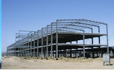
Şekil 3.24. Çelik çerçeve simtemi örneği( Url-26)
