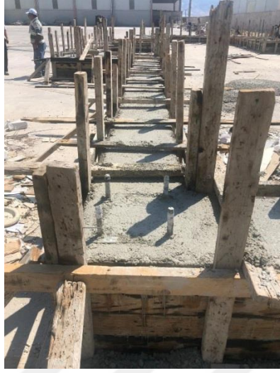
Şekil 4.26. 7 Nolu Örnek Sanayi Yapısı Yapım Aşamaları- Betonarme temel uygulaması
