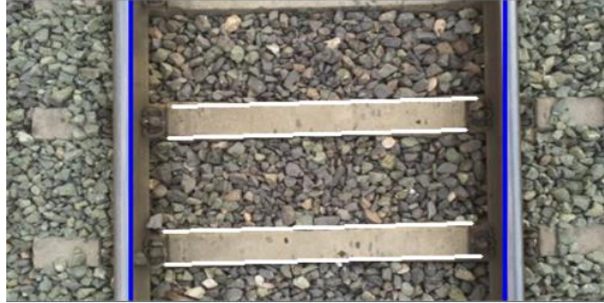
Şekil 3.15. Ray ve traverslerin tespiti
