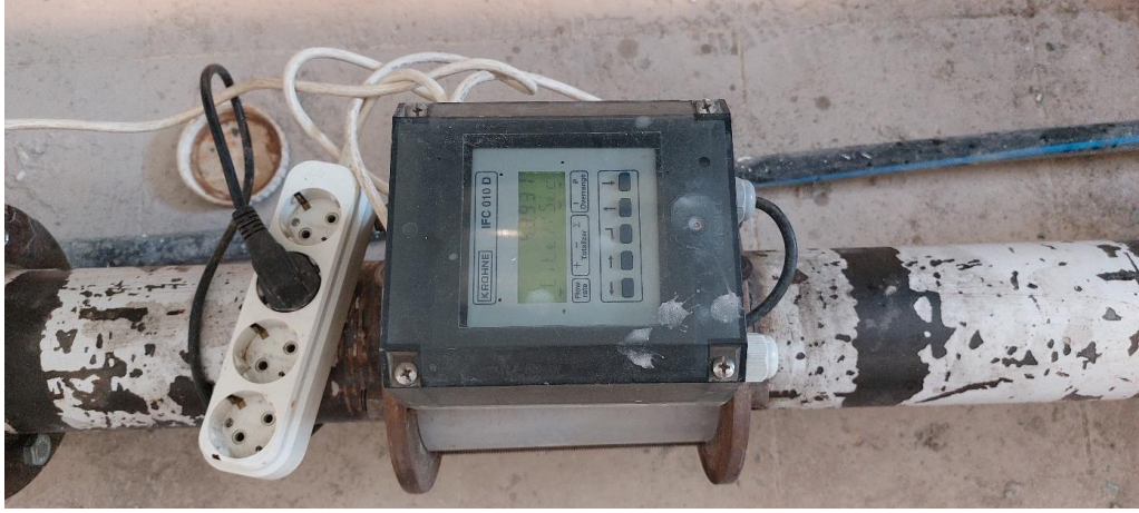
Şekil 4.12. Ana kanal debisini ölçen elektromanyetik debimetre
