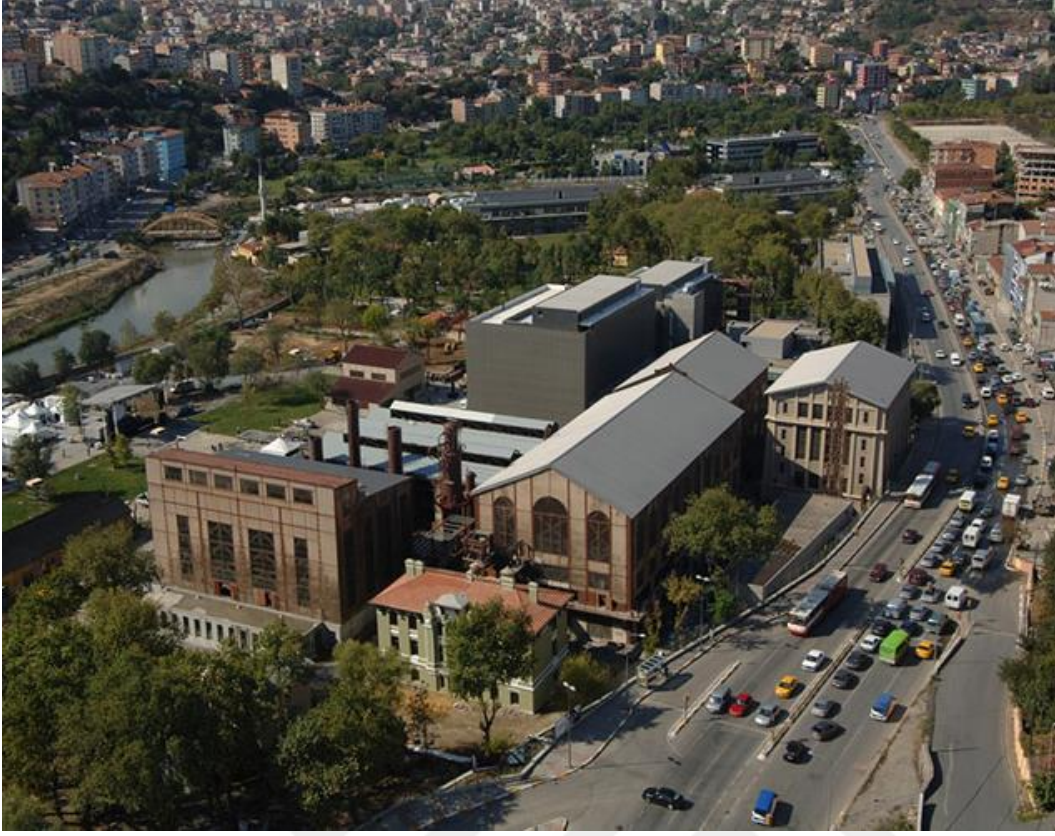
Şekil 2.27 : Silahtarğa elektrik santrali güncel hali, Santralistanbul (Url-15).
