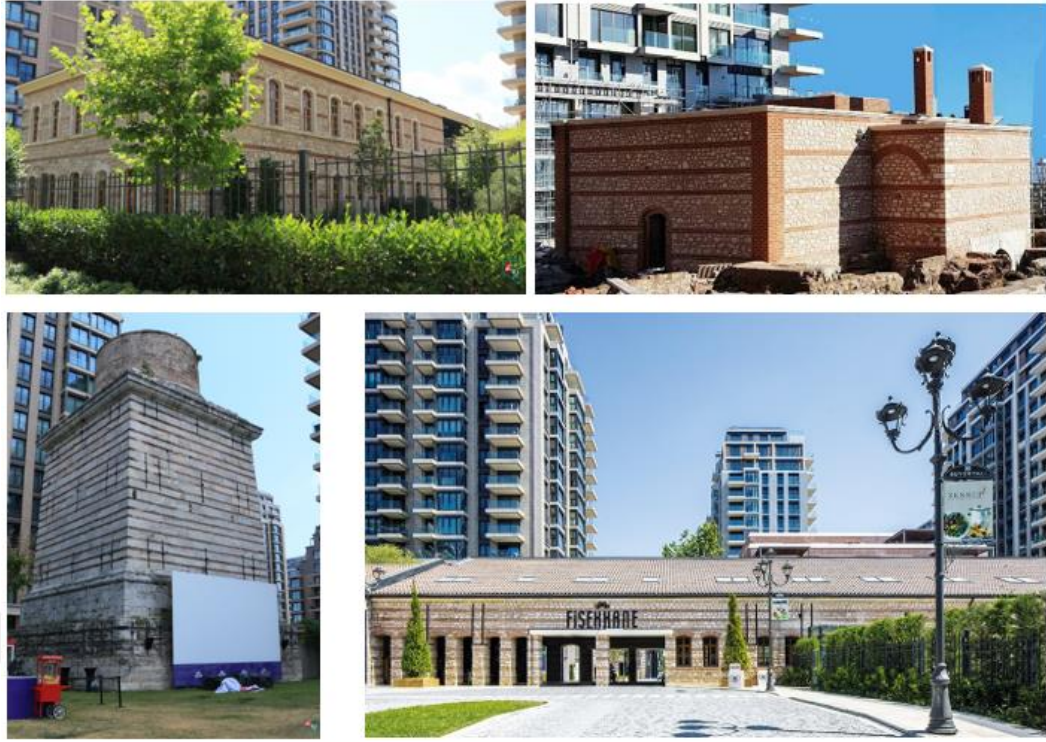
Şekil 4.21 : Zeytinburnu Fabrika-i Hümayun Demir Fabrikası restorasyon sonrası durum (Kültür Envanteri, 2022).
