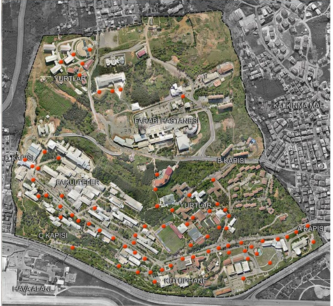
Şekil 36. KTÜ kanuni yerleşkesi hava fotoğrafı (2016) (Url 42)
