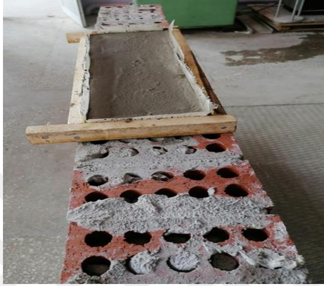
Şekil 6.2. Kemer üstü lento kiriş imalatı
