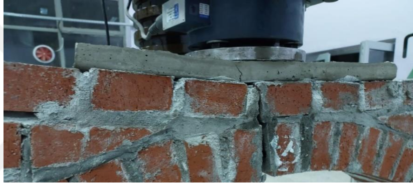
c) Göçme durumunda kilit taşı seviyesinde ayrılma
