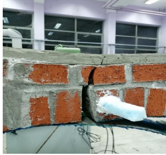
b) Kilit taşı seviyesinde ayrılma ve tuğlada kırılma
