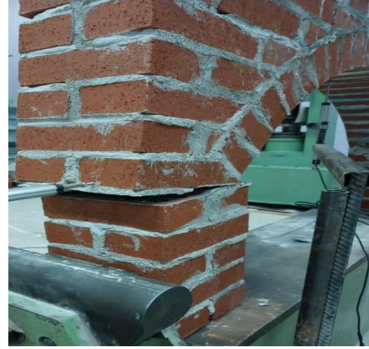
b) Göçme durumunda üzengi taşı seviyesinde ayrılma
