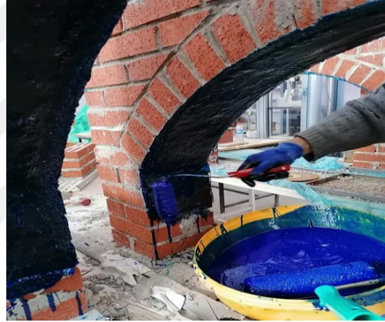
b) CFRP’nin kemere uygulanması
