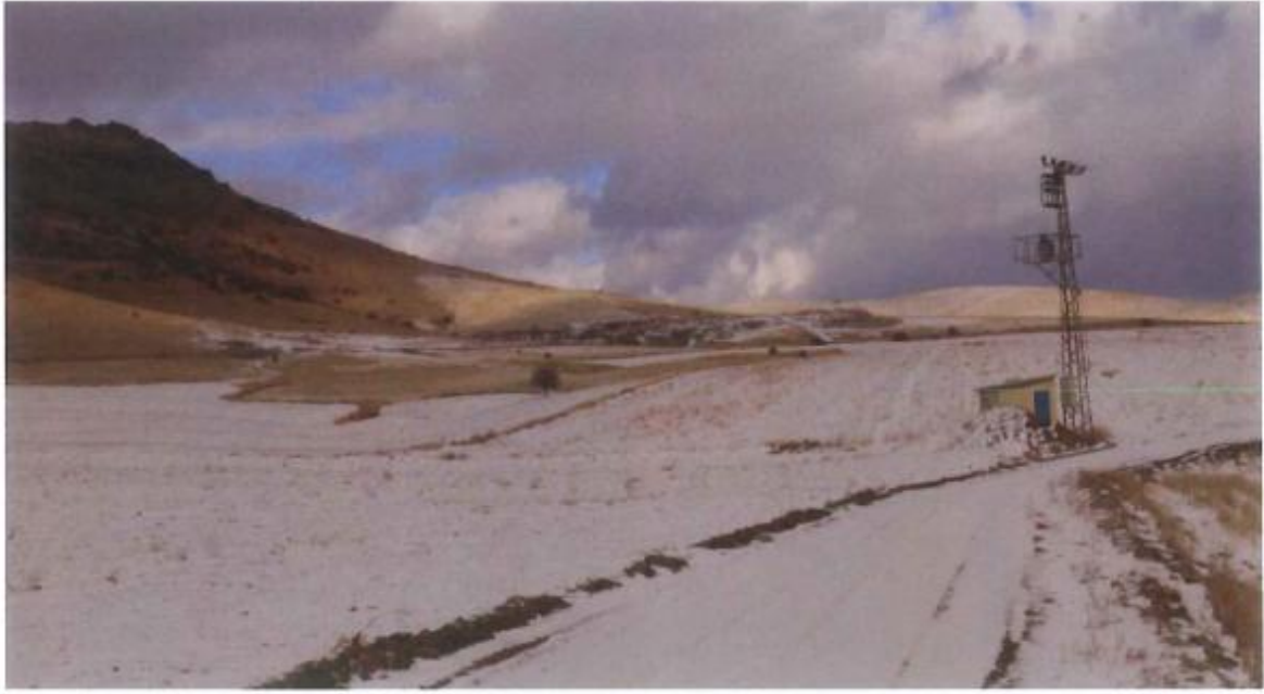
Şekil 4. 10 Karahıdır Köyüne İçme Kullanma Suyu Sağlayan Su Sondaj Kuyusu
