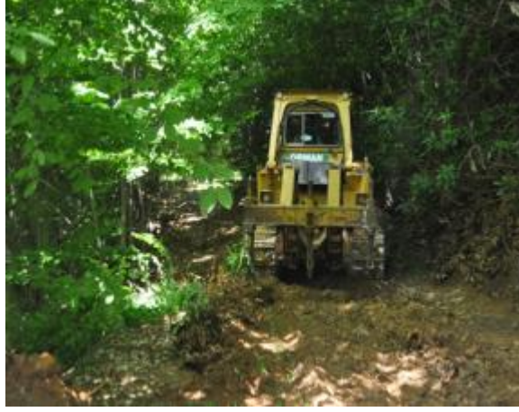
Şekil 4.4: Buldozer yardımıyla kazı ve dolgu çalışmaları
