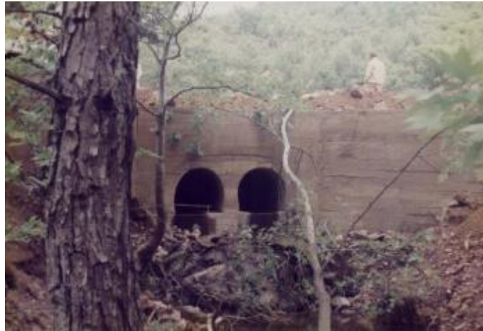
Şekil 2.9: Sepetkulpu yerinde dökme büz (Foto: T.Öztürk).
