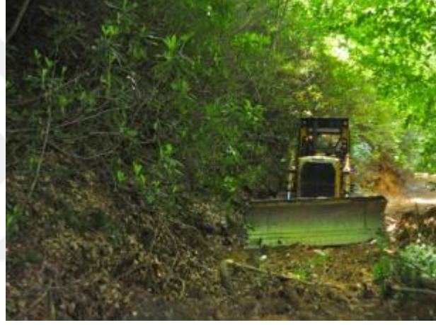
Şekil 4.5: Yol yüzeyinin temizlenmesi
