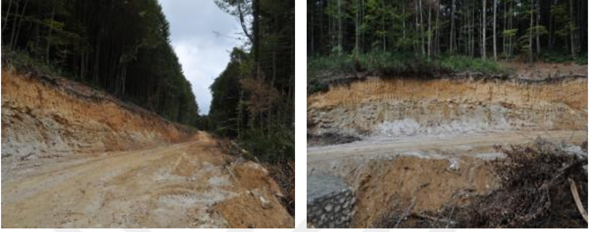
Şekil 4.6: Yolun kazı şevlerinin ekskavatörle düzenlenmiş hali
