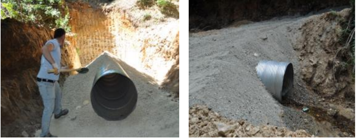
Şekil 4.9: Dolgunun yapılması
