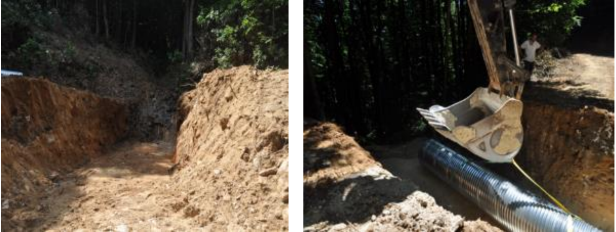
Şekil 4.7: Menfez kazılarının yapılması ve menfezlerin yerlerine yerleştirilmesi
