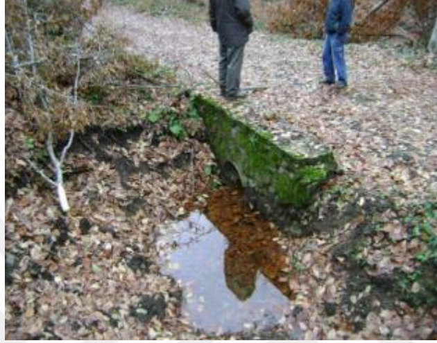
Şekil 2.8: Kenar hendeği drenajı için yapılan büz örneği (Foto:T.Öztürk).
