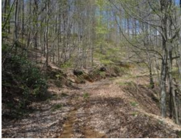
řekil 4.2: Yol gzerghındaki yzey bozulmaları
